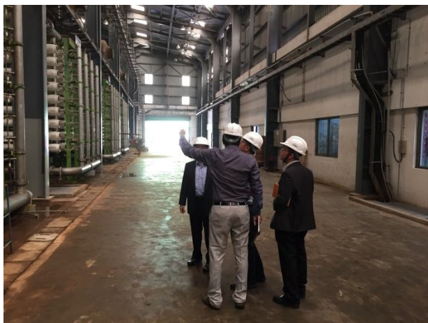
圖 32 UF 過濾系統
