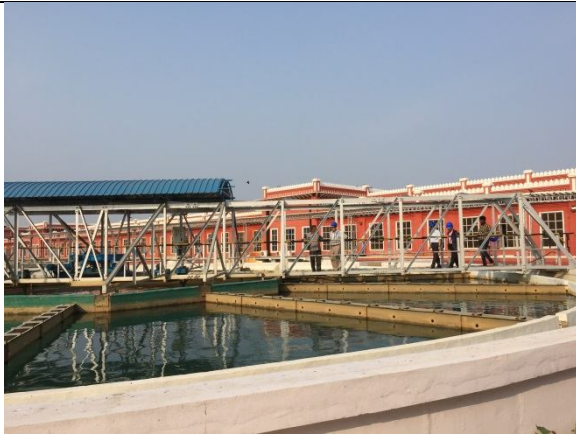
圖 53 Kilpauk WTP 快速膠凝沉澱池(1)
