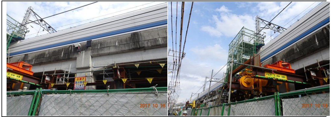
圖 3.1-11 梁底設防撞警示、托底鋼架限高及防撞
