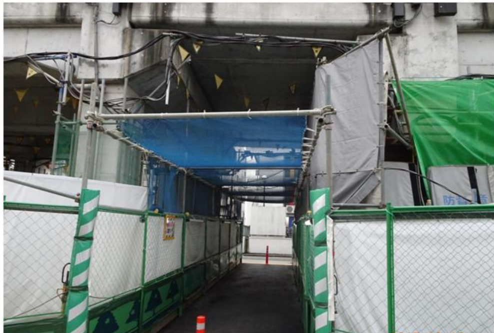
圖 3.1-18 施工通道防撞、防墜落
