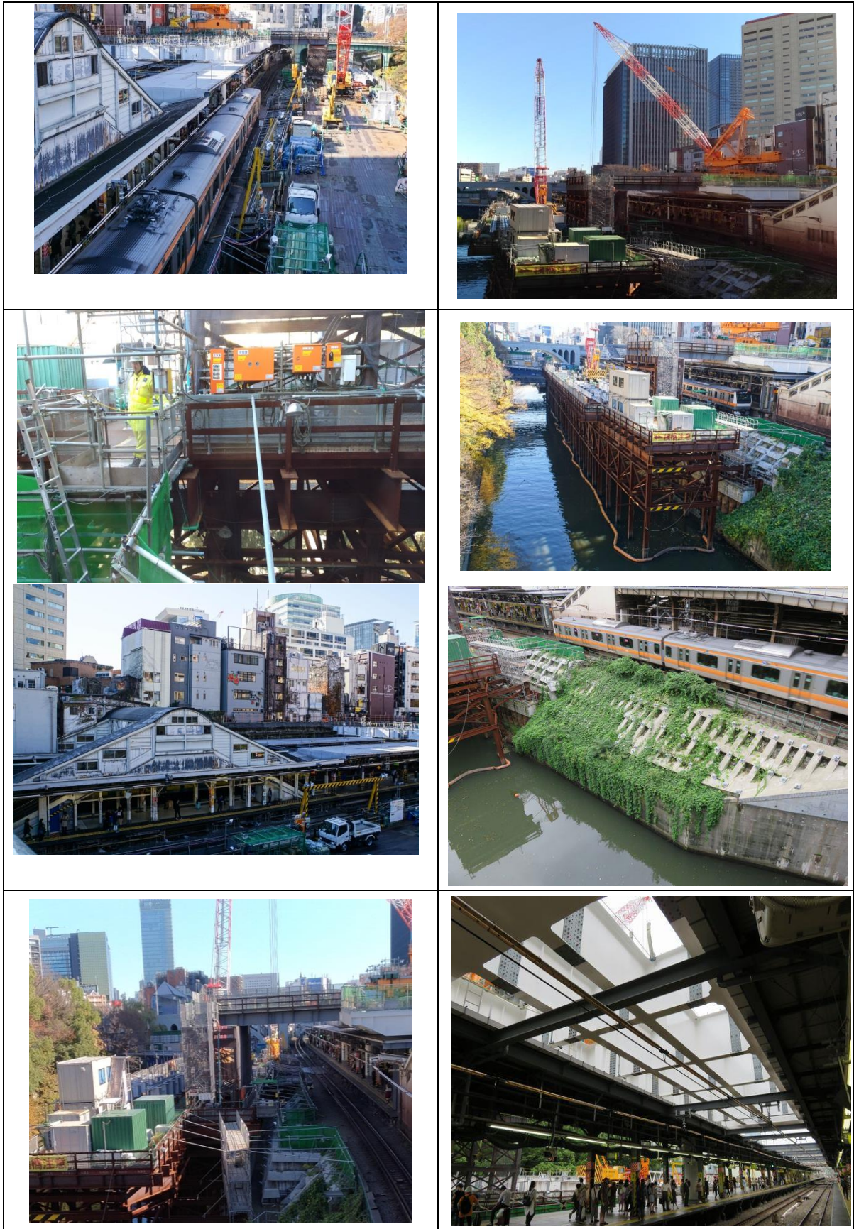
圖 3.4-3 御茶水站改建工程施工情形
