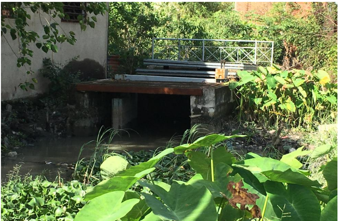
圖 2-11 淹水處排水閘門(已損壞)
