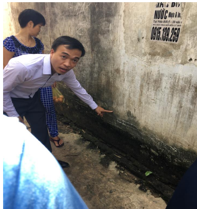
圖 2-16 鄰近房舍牆壁仍留有淹水痕跡(約達 75cm)
