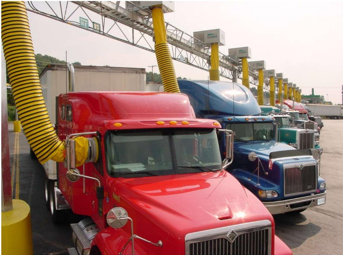
圖 3-7 停車場電氣化服務站高架供電設備
