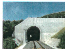
戸花山第一トンネル
