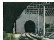
戸花山第二トンネル
