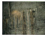
側壁 45° 裂縫滲水及粉漿現象
