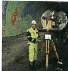
(f)瑞士 Amberg 公司 Tunnelscan 隧道影像攝影系統
