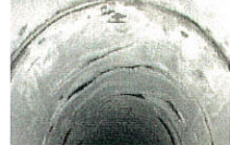
頂拱斜裂縫及硫酸鈣結晶
