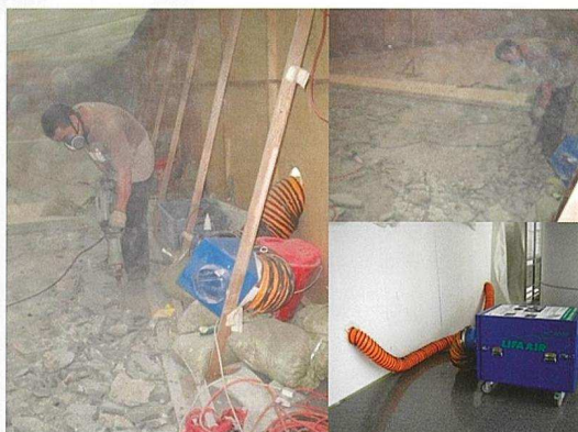
使用麗風DCS除塵風機套裝，進行清拆工程
