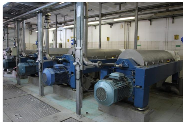
圖 3-14、Sorek 廢汙水廠發電廠
