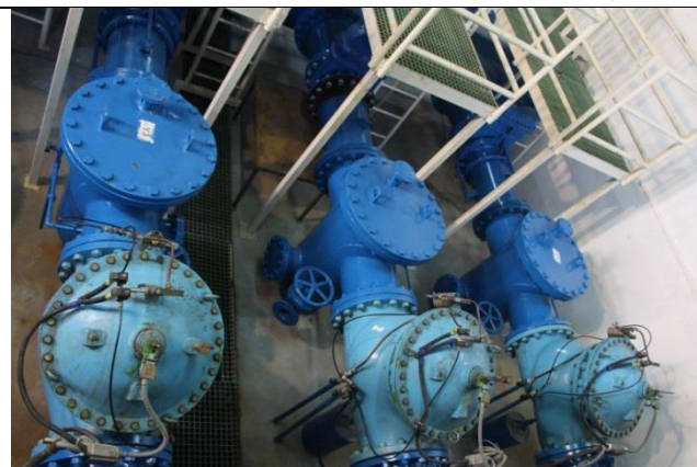
3-6、HaGihon 公司輸水管水壓漏水測試
