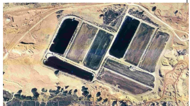
圖 3-32、廢汙水處理後地下水補注池空拍圖
