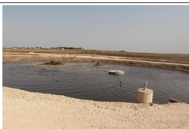
圖 3-52、畜牧廢水集中及曝氣池
