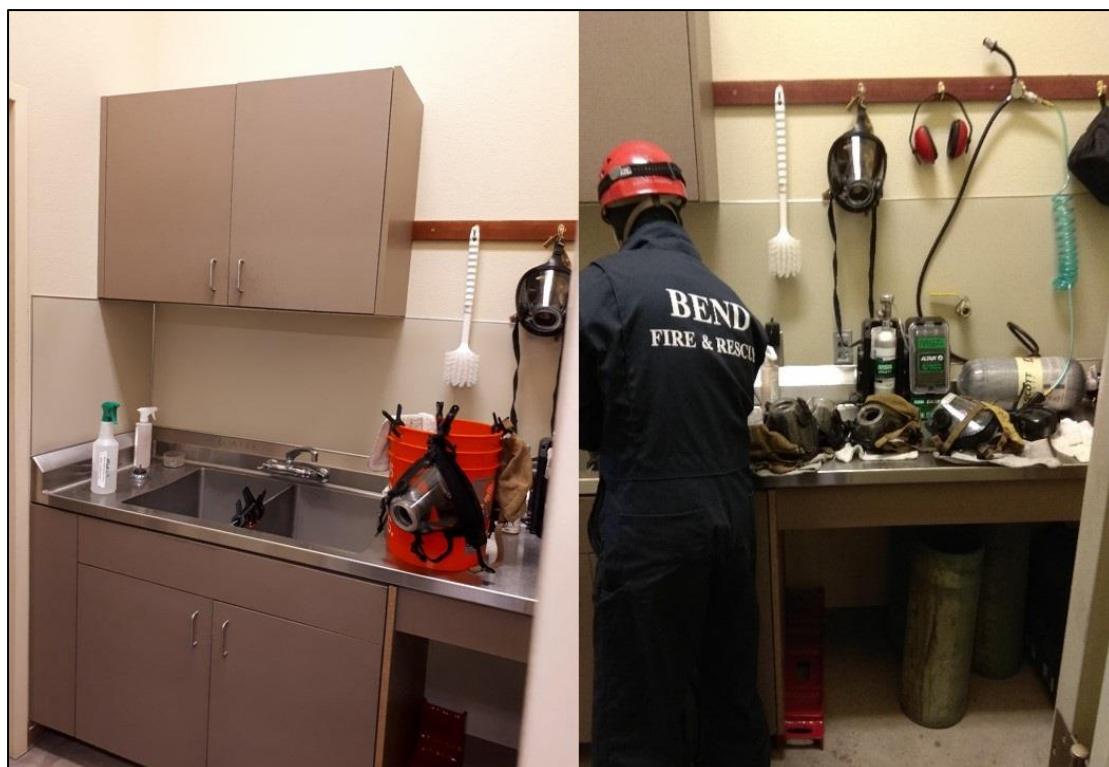
圖 37 空器呼吸器面罩清洗區水源及吹乾風槍均有配置
