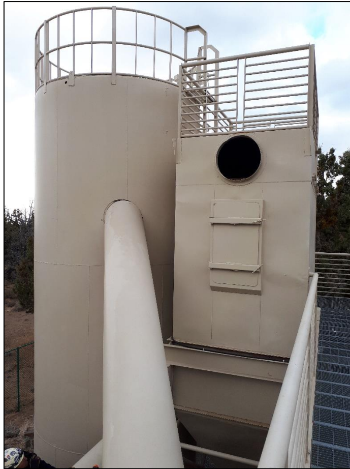
圖 16 本德市消防隊侷限空間訓練塔
