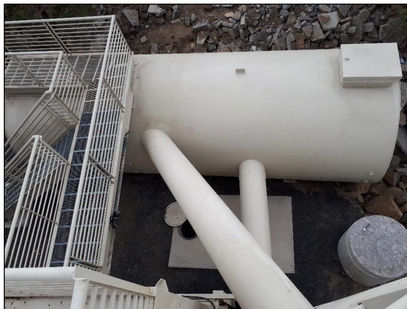
圖 17 本德市消防隊侷限空間訓練塔
