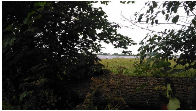
邊界倒伏木後方大型太陽能光伏電站
