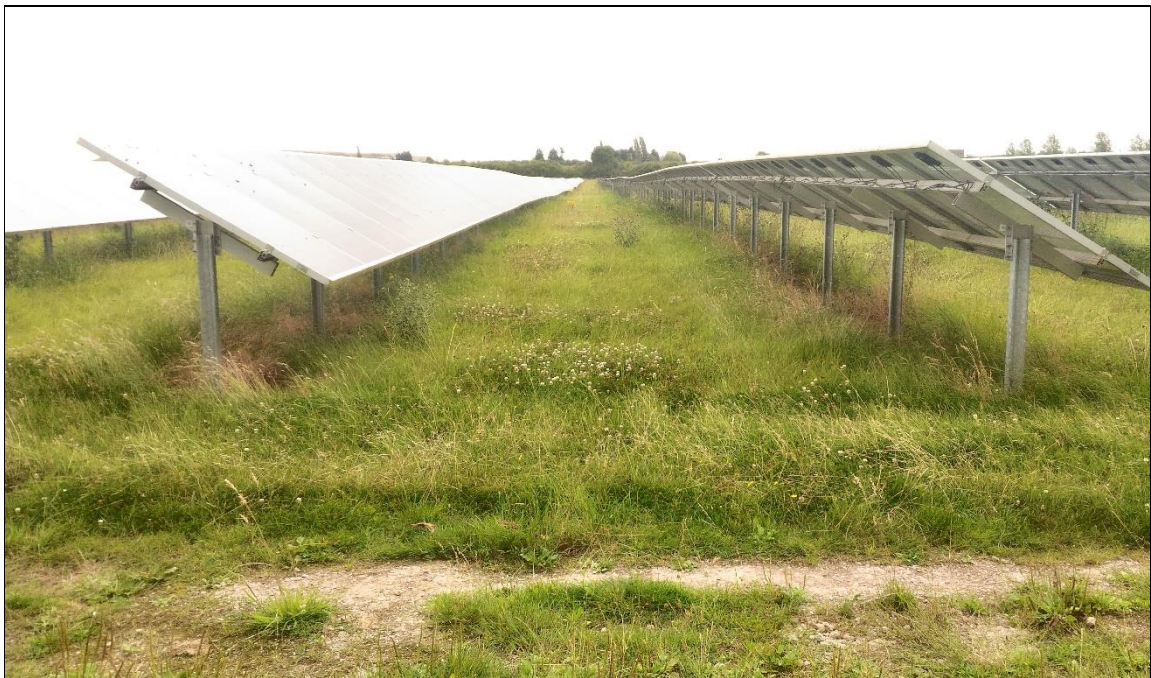
案例 C 太陽能光電模組側面相片，模組間確實留有植生空間，以利生物棲息
