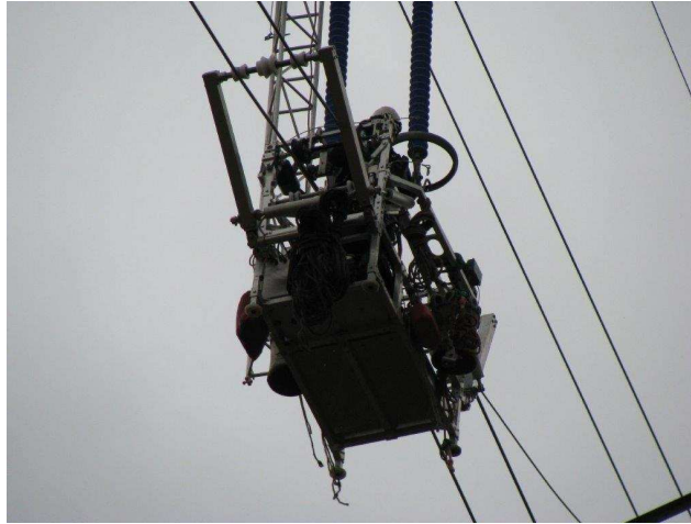
圖 13 宙乘車掛置於 ACCC 導線上
