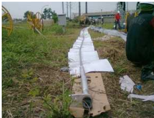
圖 4 導線與地面應使用乾淨的紙或塑料隔離
