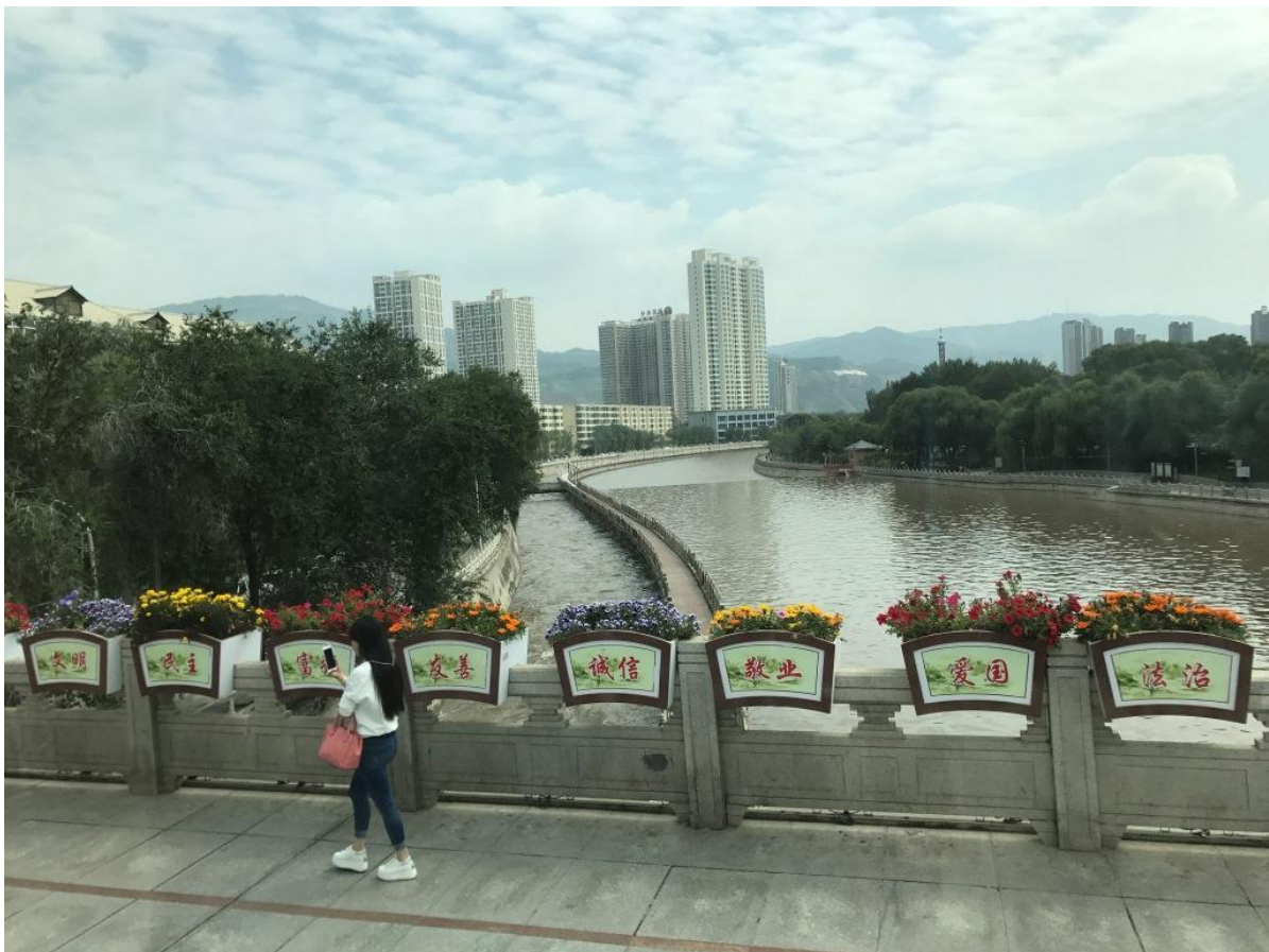
圖 26 主河道流速快(左)，內河道(右)整治後流速變緩，營造親水空間
