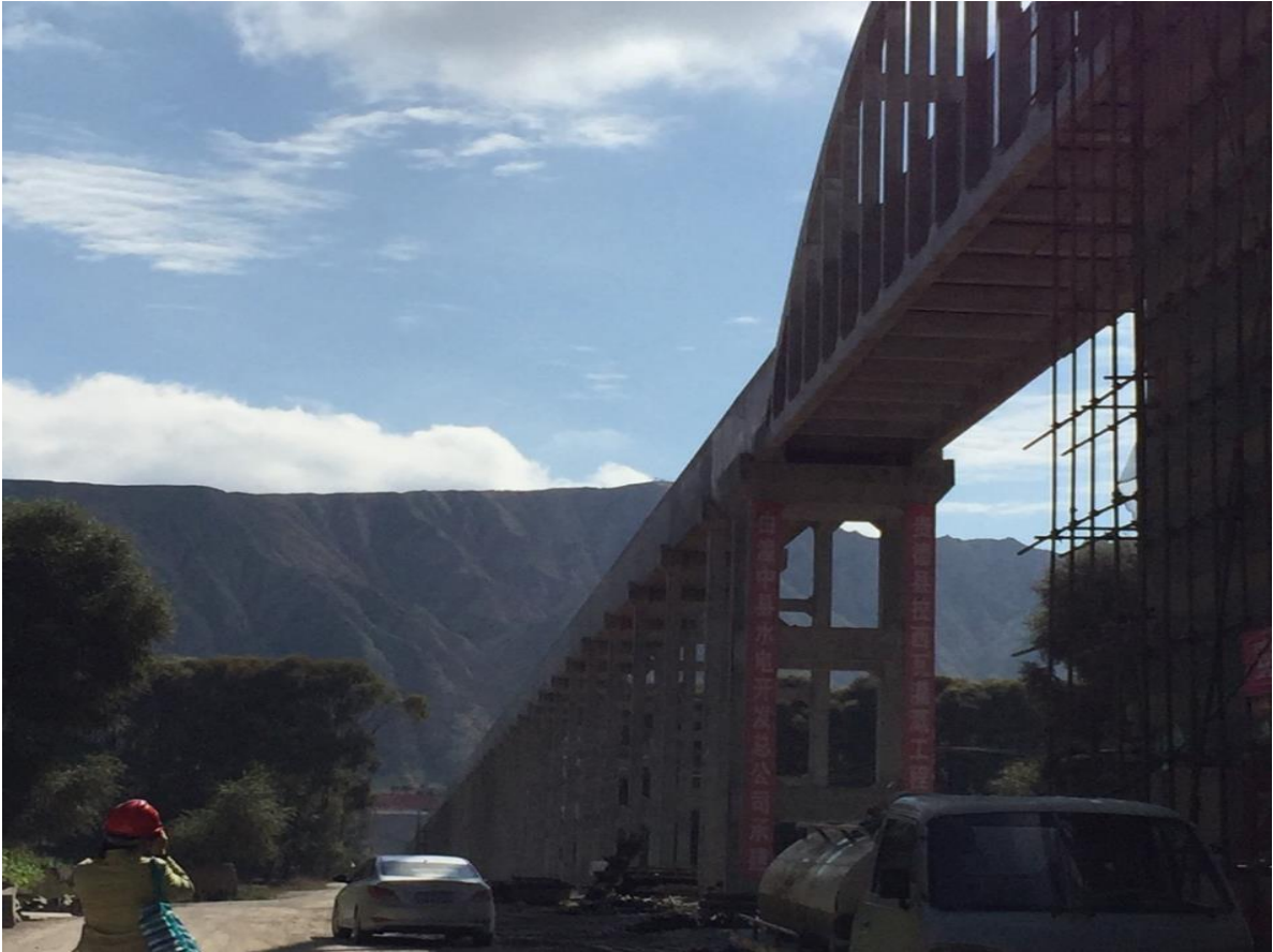
圖 30 拉西瓦灌溉工程渡槽一景
