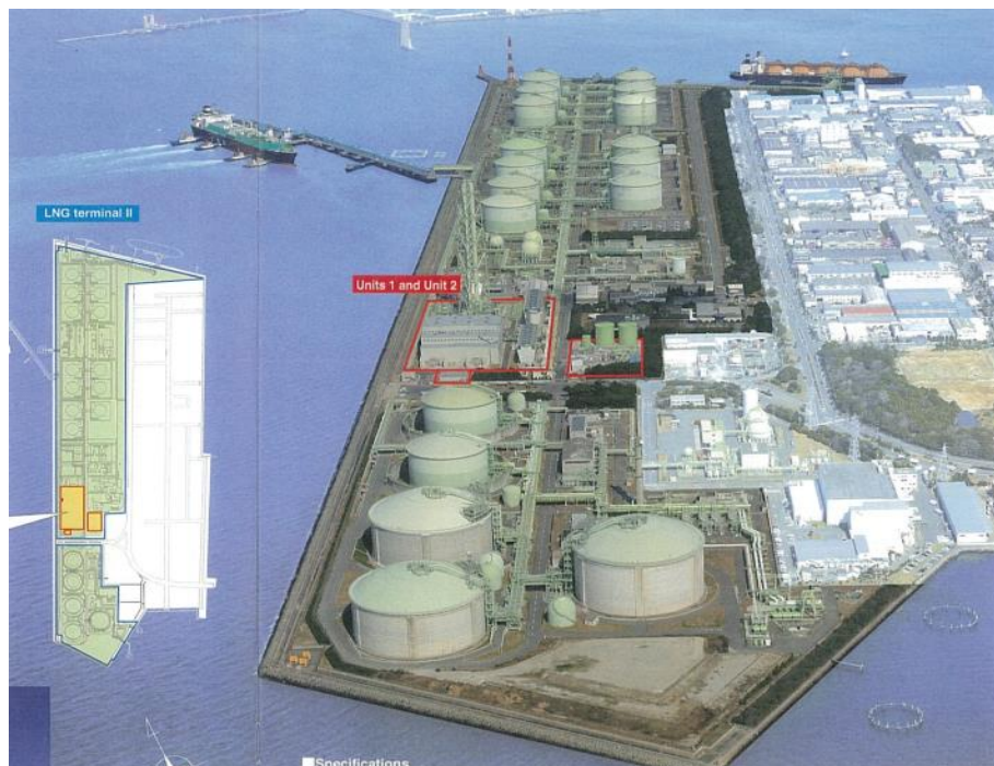
圖 13 泉北接收站 Terminal 2 複循環機組
