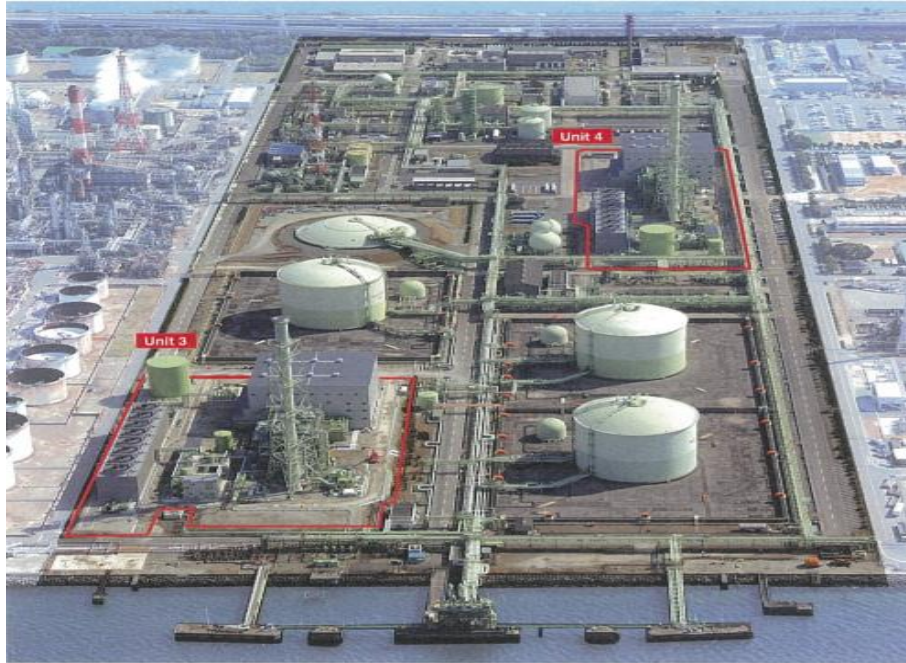
圖 12 泉北接收站 Terminal 1 複循環機組
