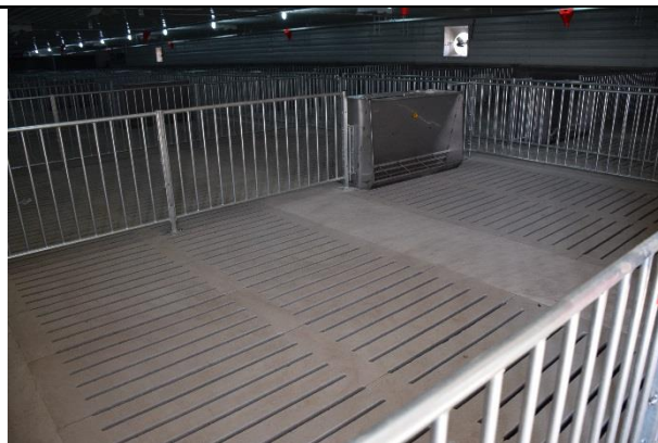
後備母豬舍，全為條狀地面，下為刮糞系統，留設維修孔。
