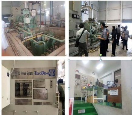
發電廠：以粗糠當蒸氣鍋爐燃料年發電 500 萬瓦，除該廠區自用，也提供其他廠區使用
