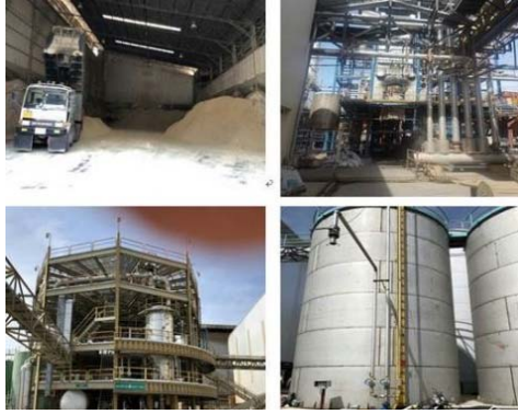
煉油廠：預熟米米糠製作米糠油，榨油率可高達 22-24%，比一般高出 1-2%
