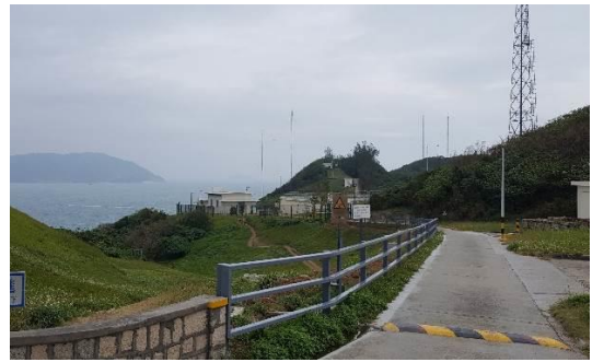
鶴咀燈塔無線電台管制區
