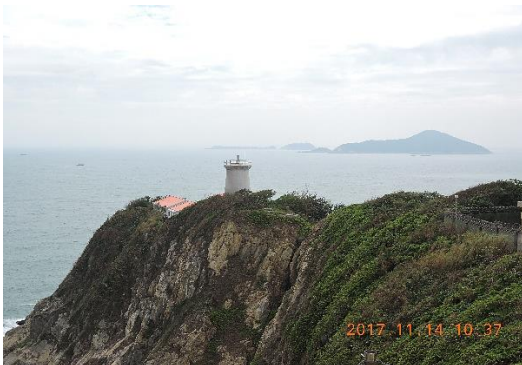
鶴咀燈塔鳥瞰全景
