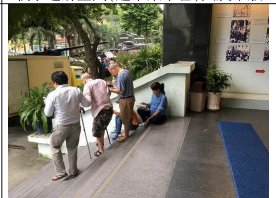
出入口未設置無障礙設施
