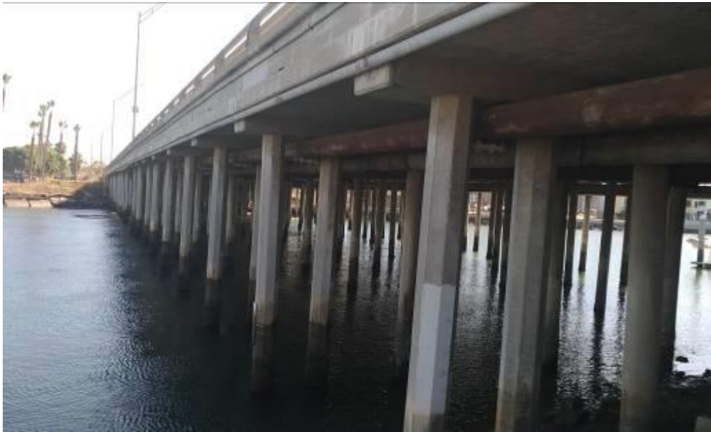
參訪洛杉磯 Alamitos Bay Bridge
