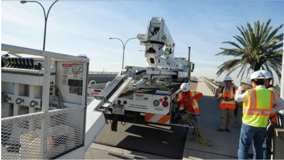
洛杉磯 Queensway Bridge 橋梁檢測前討論
