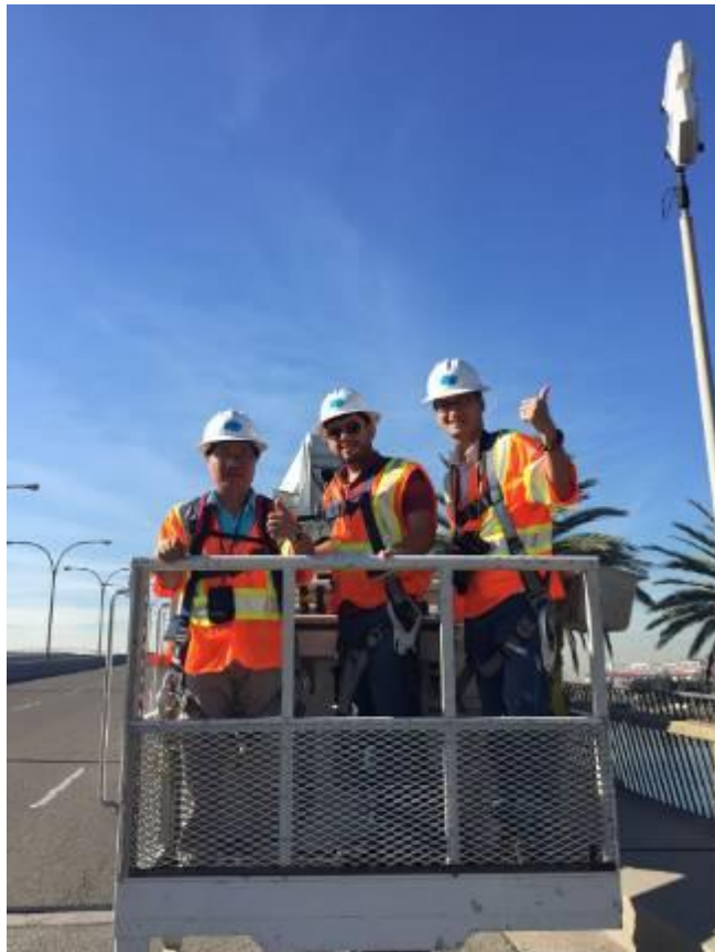
洛杉磯 Queensway Bridge 橋梁實際檢測情形
