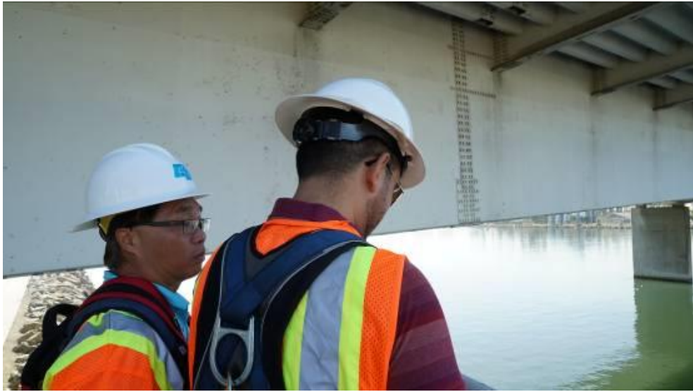
洛杉磯 Queensway Bridge 橋梁實際檢測情形
