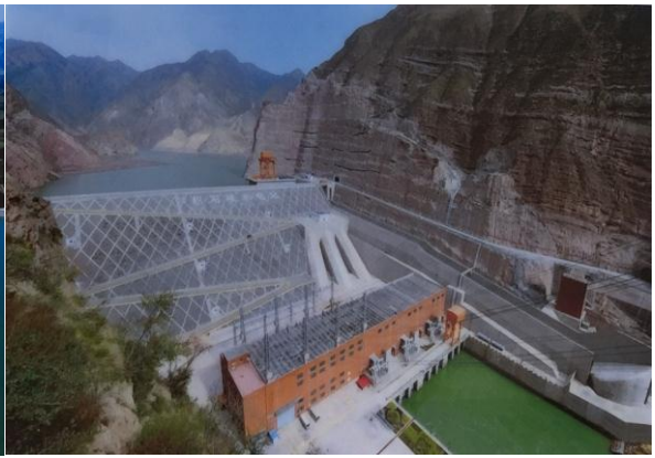
圖 17 積石峽水電站
