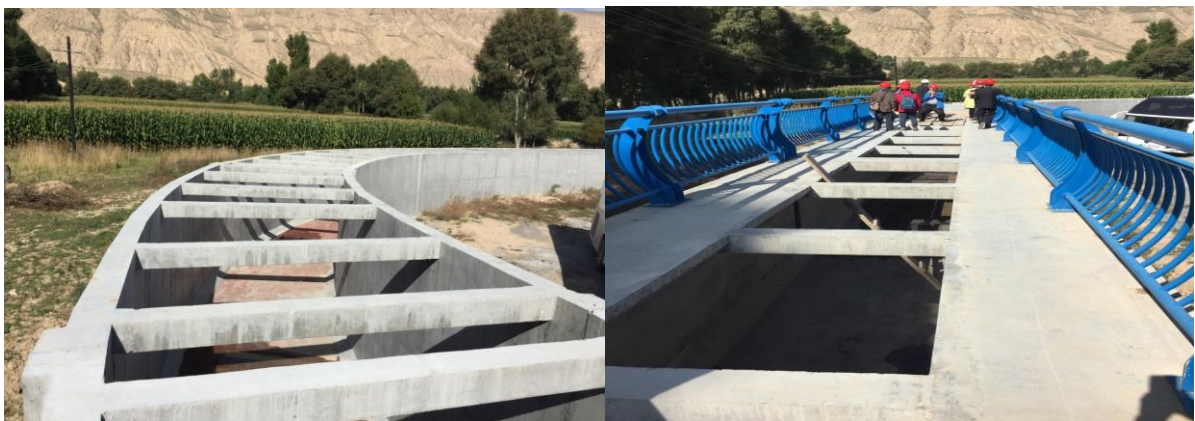
圖 28、圖 29 拉西瓦灌溉工程明渠一景
