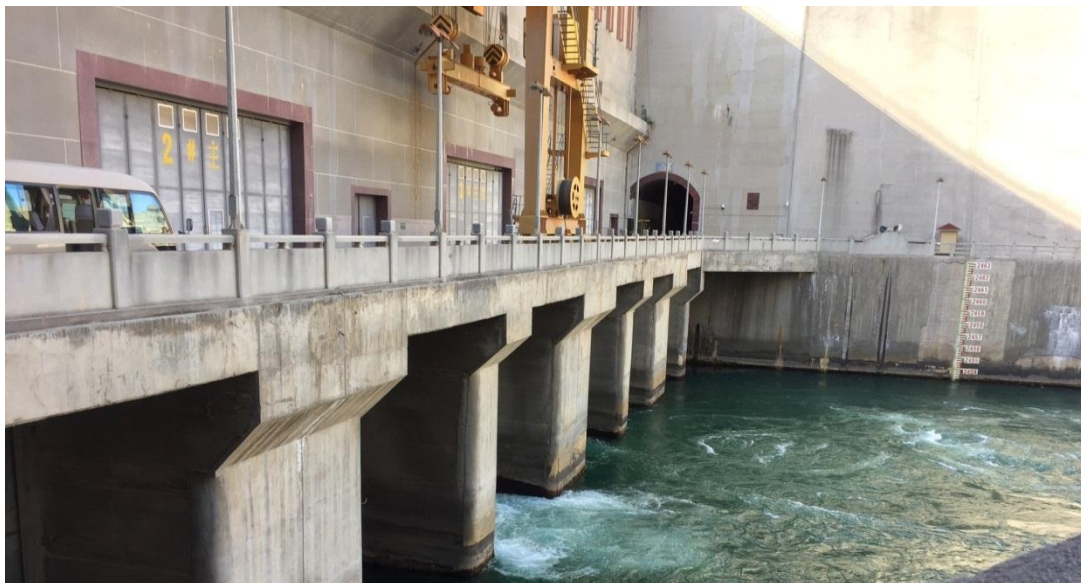
圖 22 龍羊峽水電站尾水放流口
