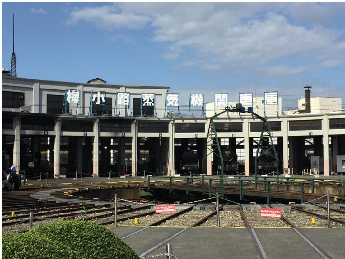
圖：梅小路機務段內的半圓弧狀扇形車庫及轉車盤
