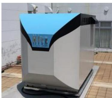
圖 14. 日立造船固態氧化物型燃料電池
