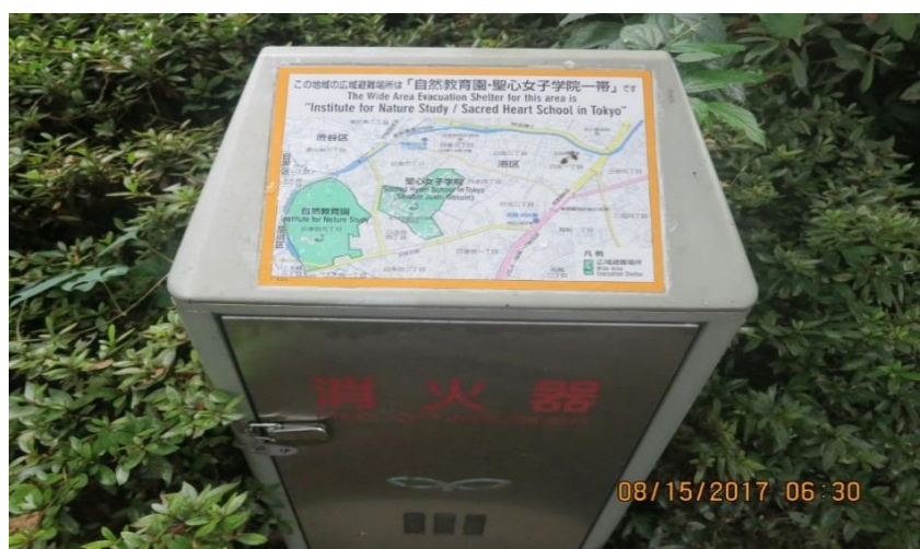
圖 16 街道設置消火器(1/2)
