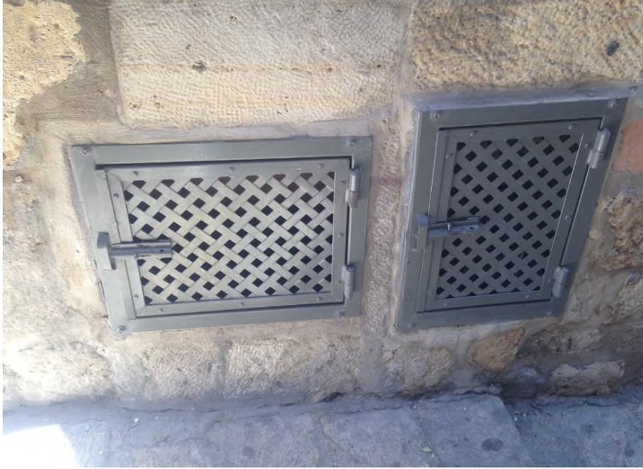
圖 25：耶路撒冷乾式 B 級機械式水量計箱(嵌入牆壁)
