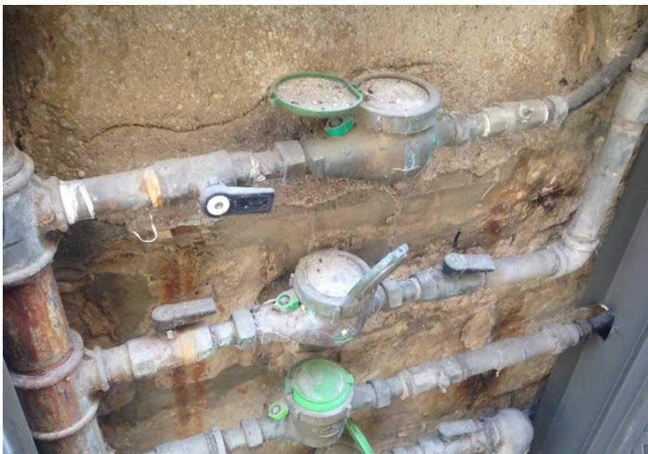
圖 24：耶路撒冷乾式 B 級機械式水量計
