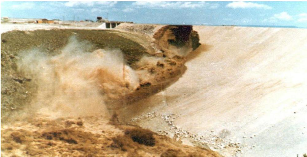
圖 18 Teton壩破壞程度持續擴大
