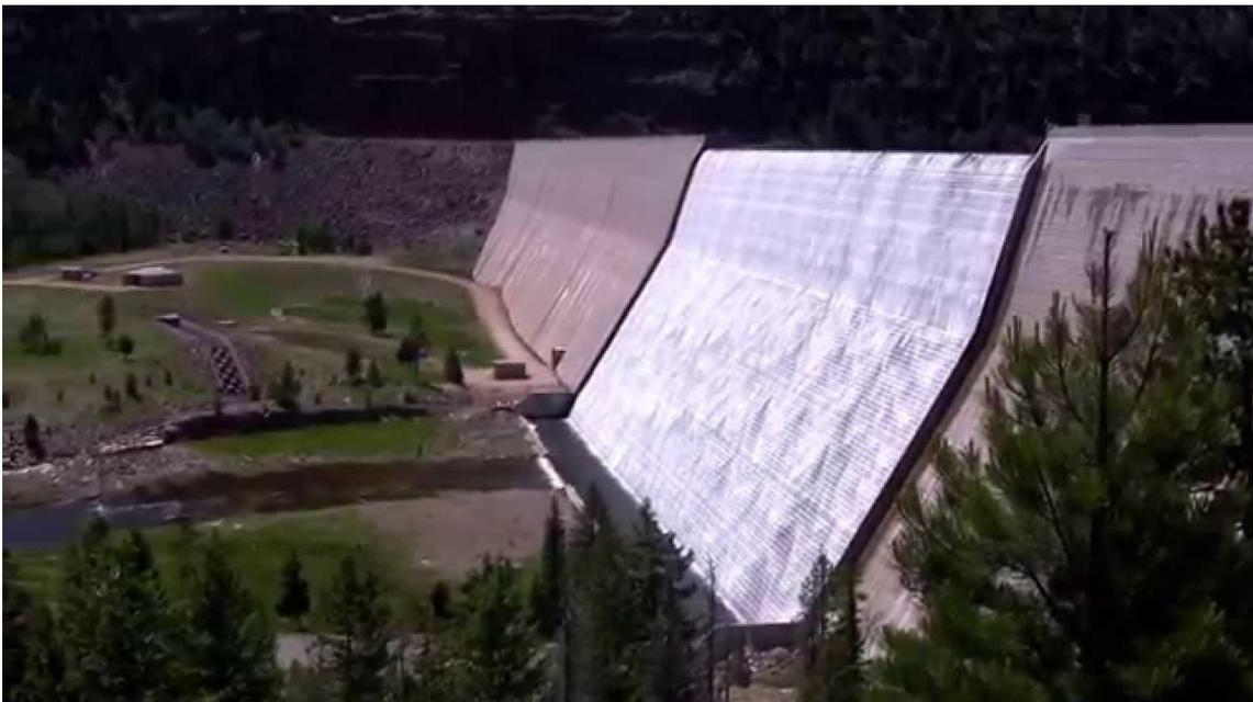
圖 32 Upper Stillwater Dam 自然溢洪後階梯跌水
