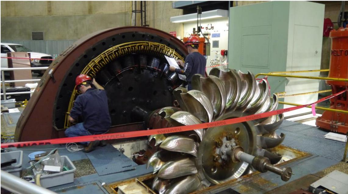
圖 49 Hoover Dam發電機葉片維修情形
