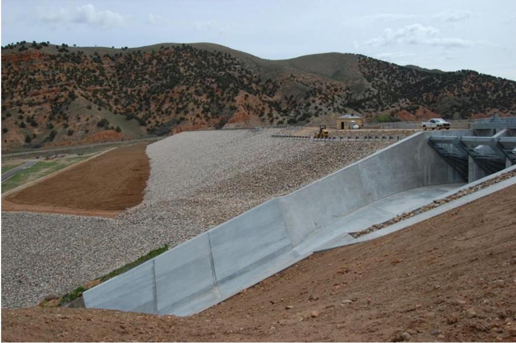
圖 38 Echo Dam 下游側及溢洪道出口
