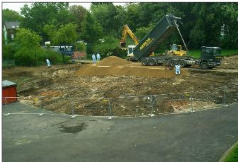
圖附錄 1-7、拆除、填土
