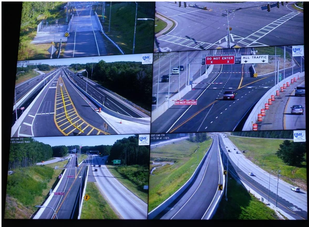
圖 37 I-75 出入口管制監控 CCTV
