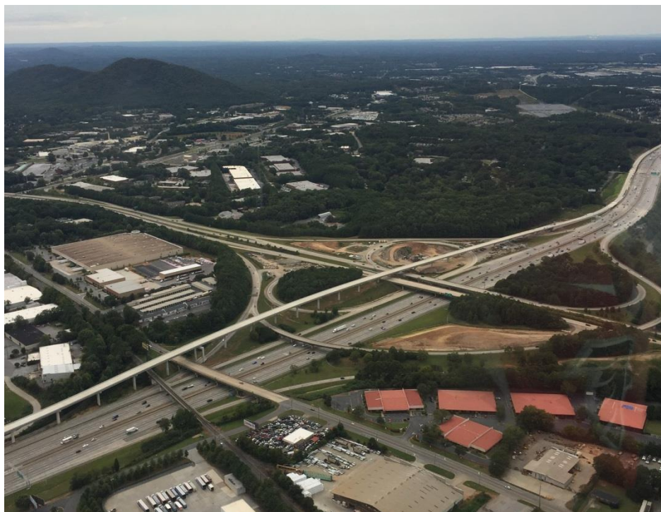
圖 41 增設中之跨越交流道快速車道
