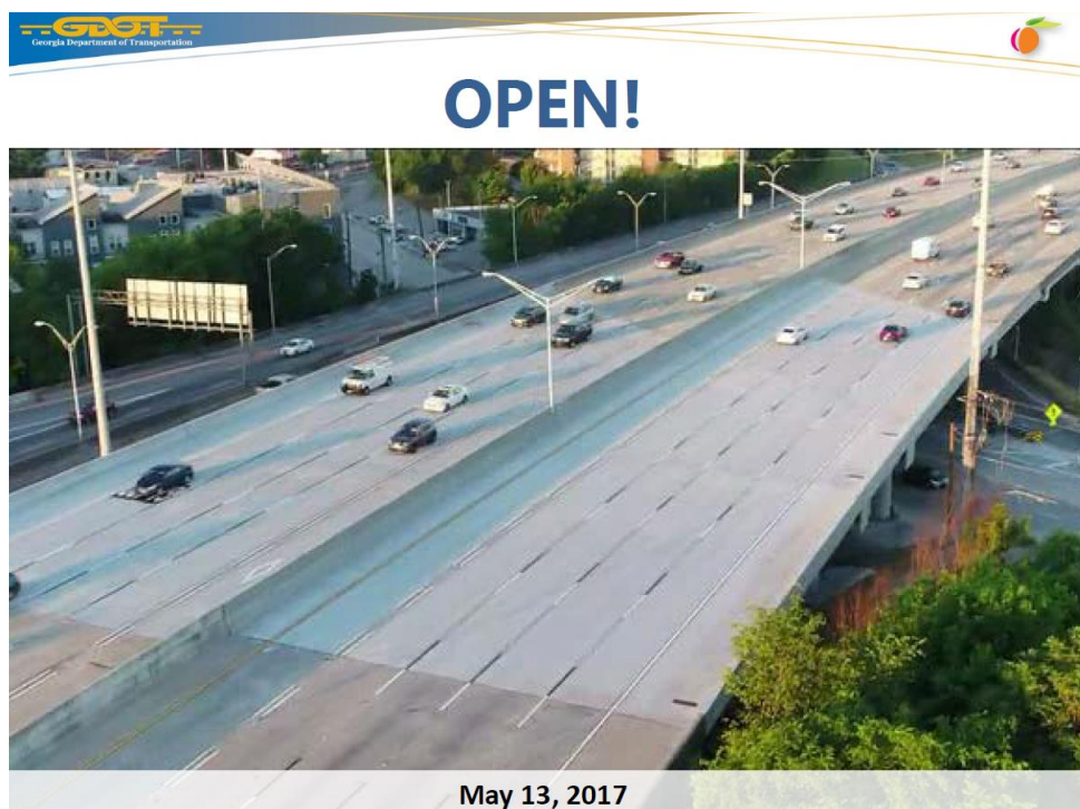
圖12 橋梁重建於5月13日提前開放通車
