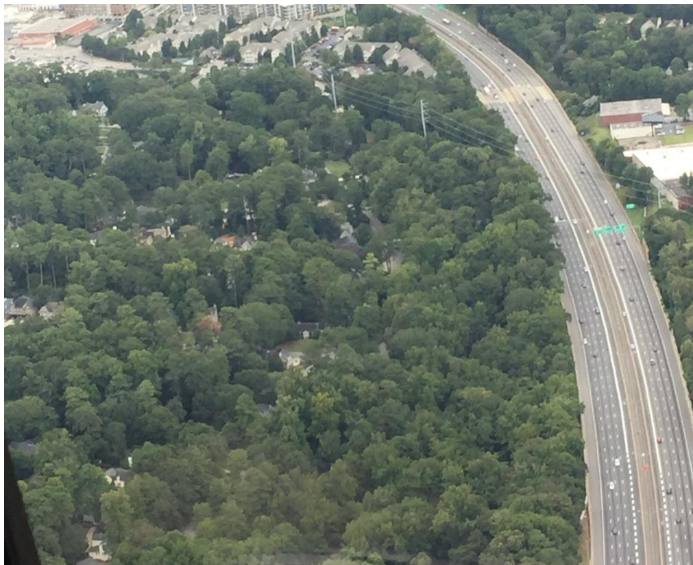
圖 39 空中鳥瞰 I-85 之 HOT 車道區隔標線
