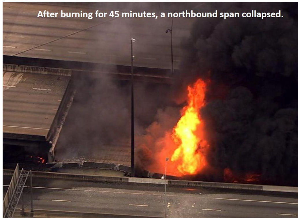
圖9 燃燒45分鐘後斷橋
