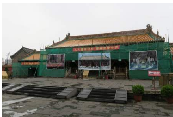
瀋陽故宮崇政殿修復中假設工程張貼圖片。
