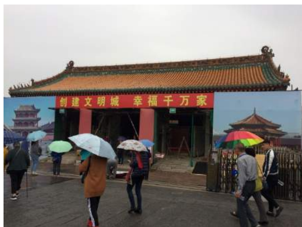
瀋陽故宮大清門修復中假設工程張貼圖片。
