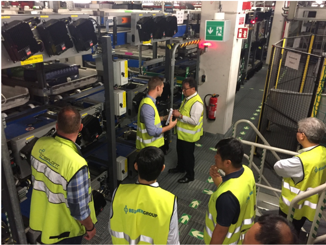
圖 58：杜賽道夫機場 ICS 設備實測
