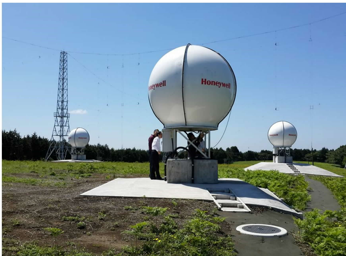
圖 3 MEOLUT 天線基座（基座前方與機房前都可看到人孔蓋）
