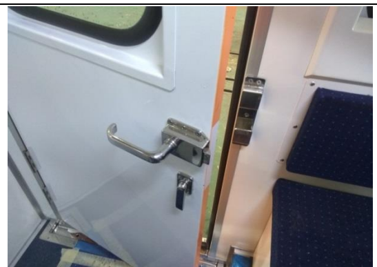
車門下方有無滲水
