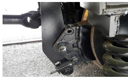
檢視闸瓦安全距離
