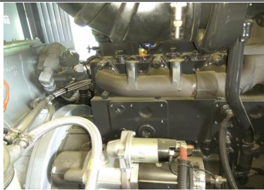
檢驗引擎室狀況
