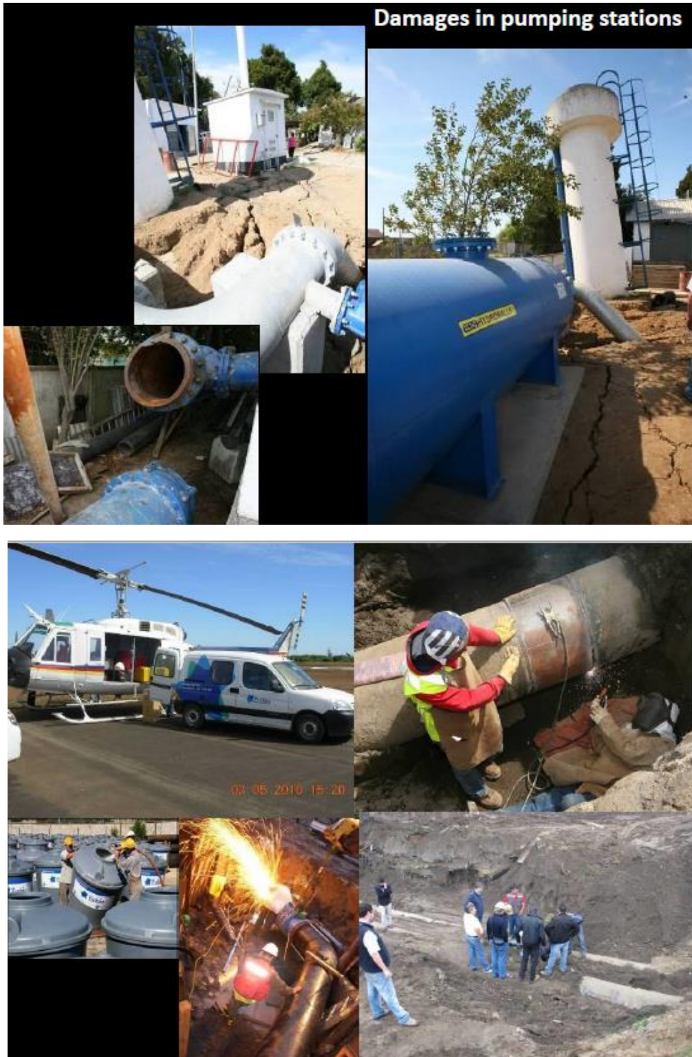
大地震造成公共基礎設施嚴重毀損
