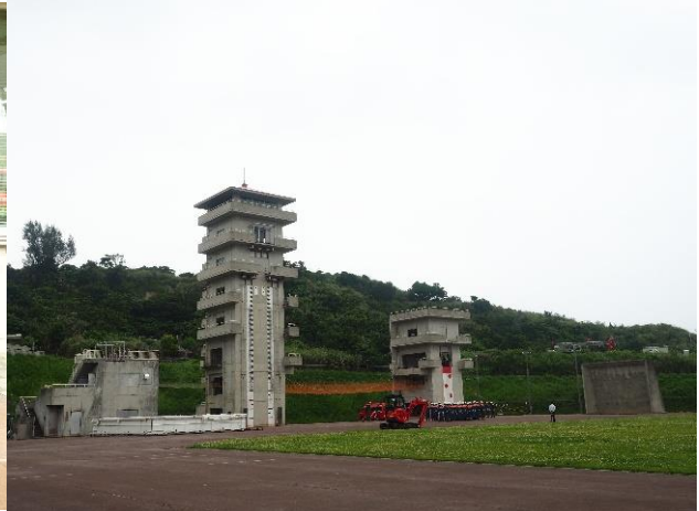
圖 37 消防學校訓練設備
