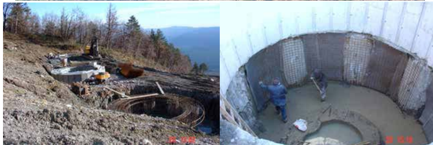
圖 25、設置 12 座大型地下水排水豎井，降低深層地下水壓
