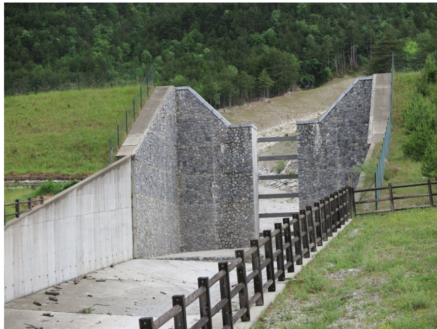
圖 31、本地區三坑溝之輸砂渠道、沉沙池等設施
