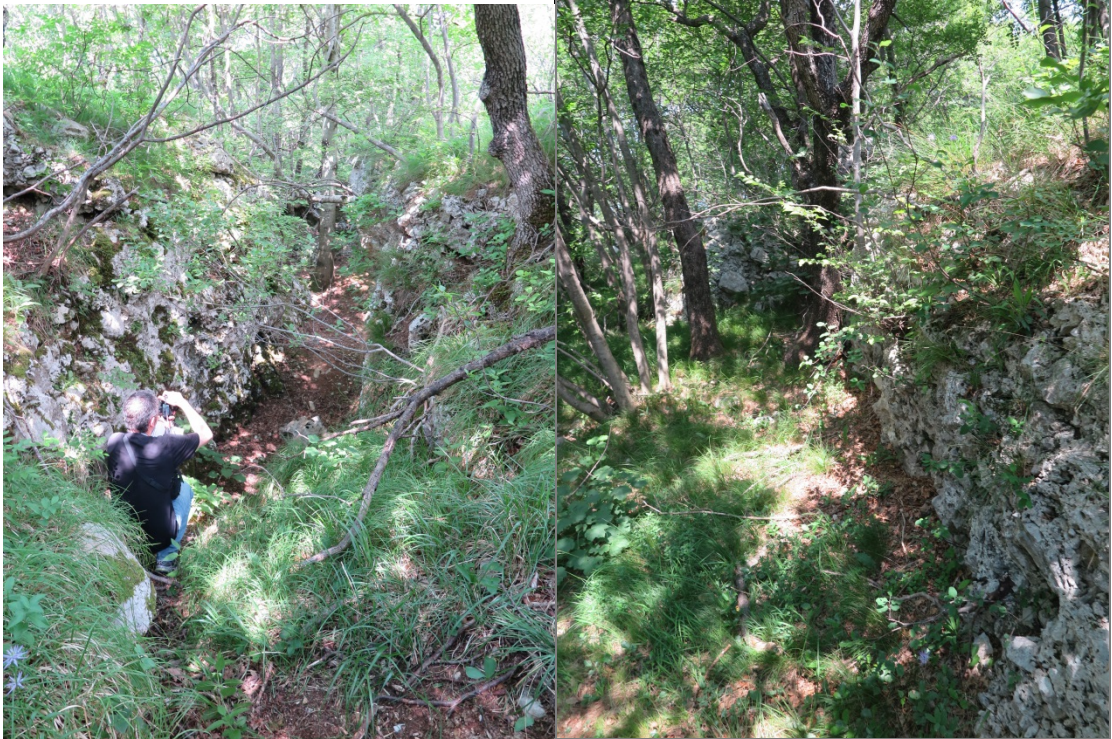
圖 22、坡體出現許多裂縫(左)及崩崖(右)，開口可達 5m 以上
