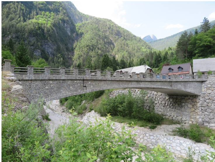
圖 29、Log pod Mangartom 村上游建立一座大型 11 米高的鋼筋混凝土防砂壩以保障居民安全
