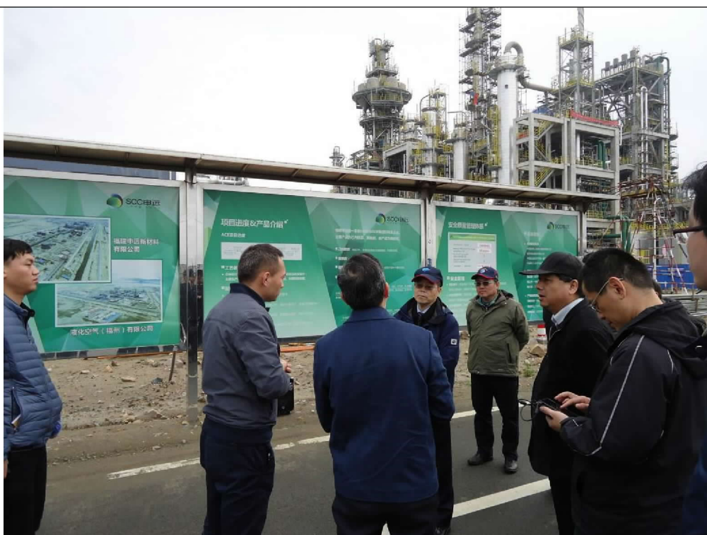
參訪可門經濟開發區-己內酰胺廠建設
