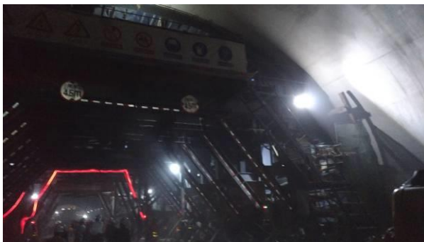
隧道襯砌施作
