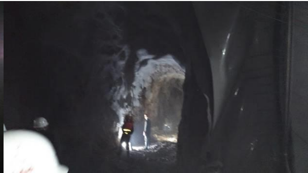
隧道內車行聯絡道施工2
