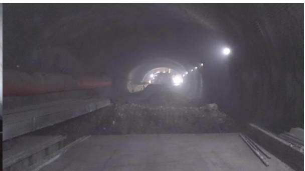
隧道鑽炸施工
