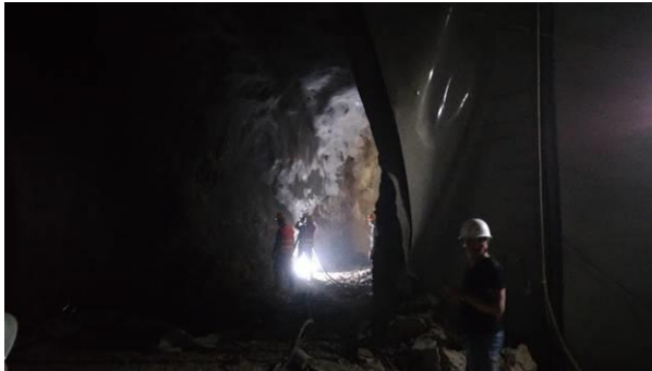
隧道內車行聯絡道施工1
