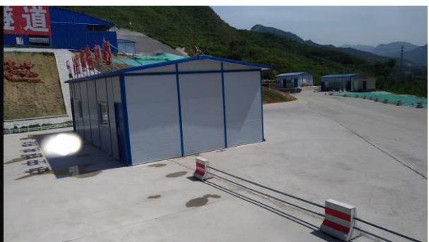
隧道外部工地環境
