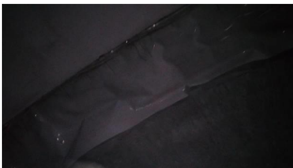
隧道防水層施工
