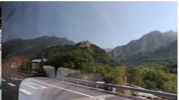
京藏高速公路外側護欄
