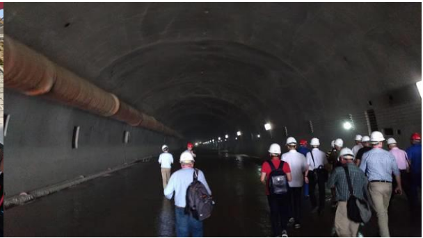
施工中隧道內
