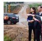
埔里大坪頂排水不良 縣長:修繕
