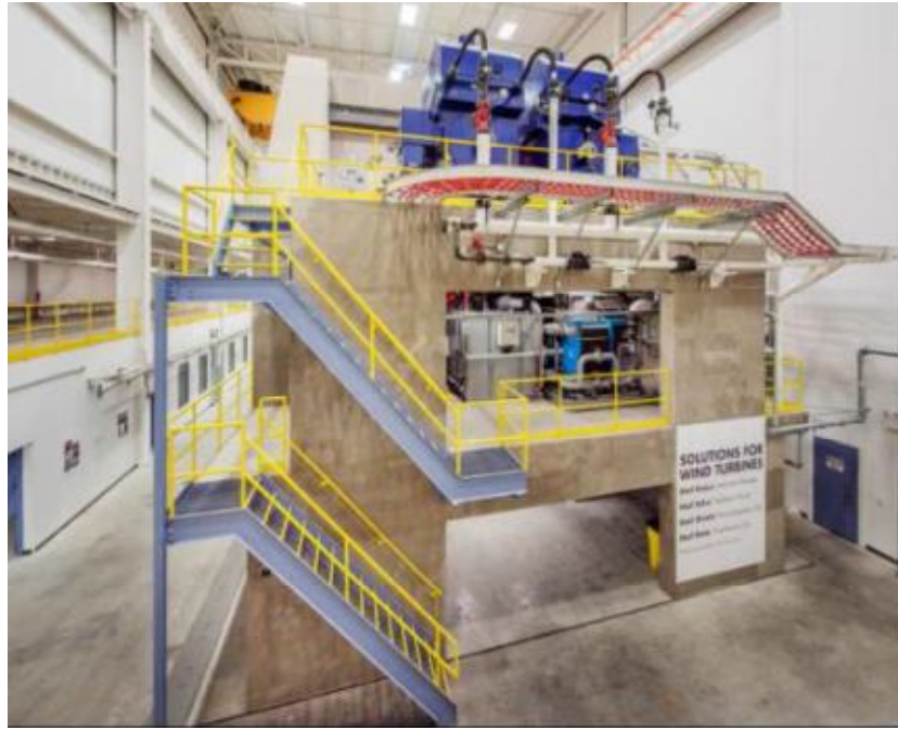
圖 16 機艙組測試基礎工程
