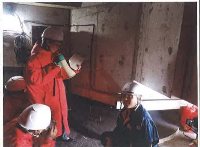
日冷物流集團東荻島物流中心避震設備
