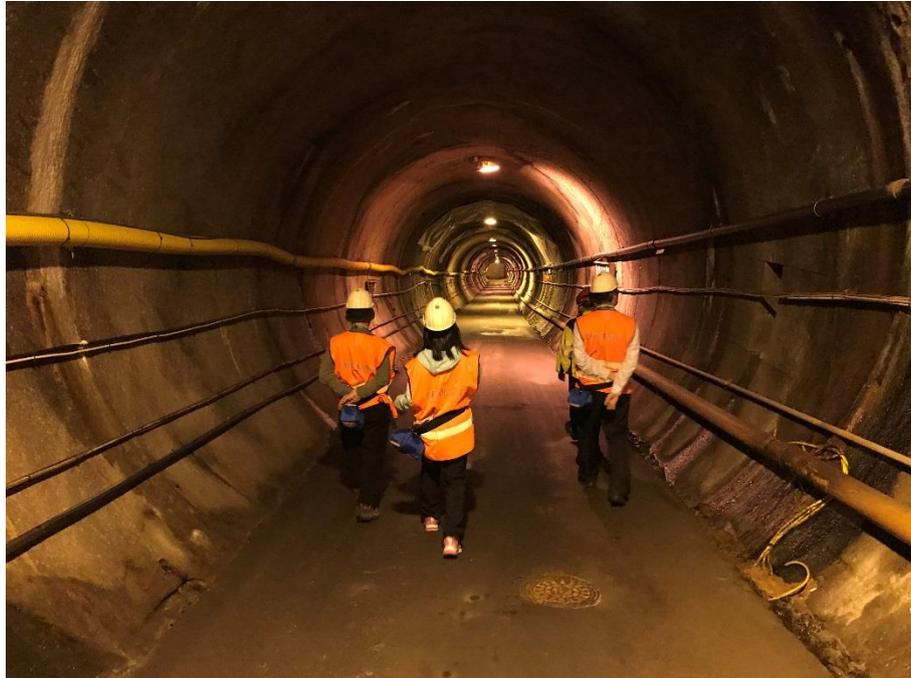
圖 42：採用全斷面挖掘機開挖之坑道
