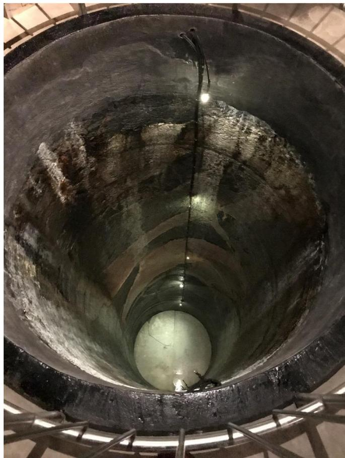
圖 46：Äspö 硬岩地下實驗室展示用之處置孔
