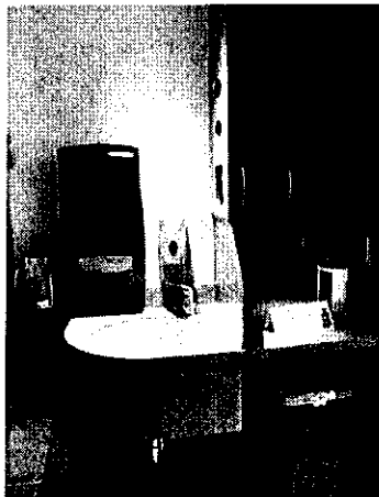
獨立洗手設備
