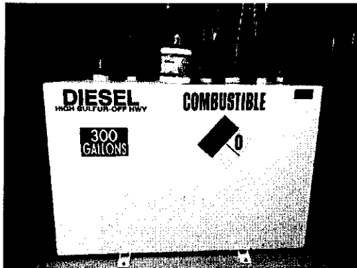
發電機油料槽
