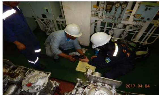
圖 20 進行船上含油樣品採集作業
