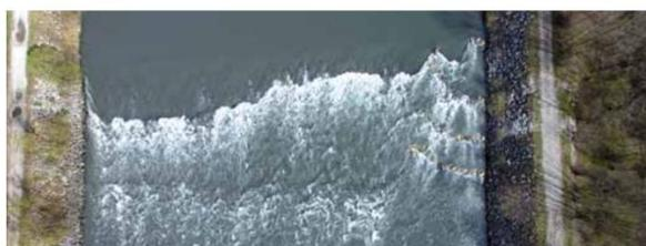
因為上游兩條支流的連結增加了流速，進而影響迴流的魚，為減緩它的速度、避免渦流，在左岸設置了三個類似丁壩的構造物，其使用 90 立方米的拋石鋪設而成。這樣的安排下，恢復鱒魚、茴魚和其他鯉科魚在此河道自由流動。
