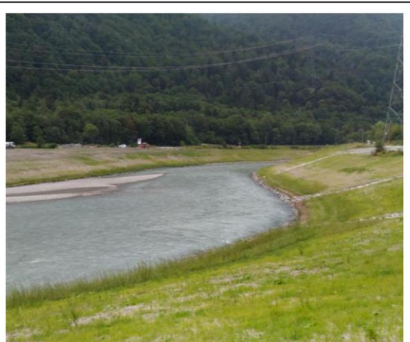
圖 4.1-2 該區域河段目前施工中，此為河岸草種植生情形
