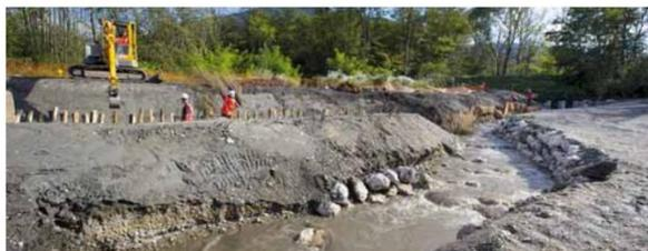
這兩條坑溝(Le Fay, Le Renevier)因早期的治理被分開幾百米，他們現在重新規劃在伊澤爾省得以匯集成合流。並加入曲流及跌水的設計，藉以控制流速。而舊有的野溪，其流路都被保存下來，在有水流入的情況下提供。
