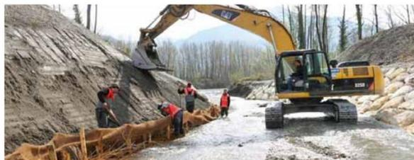
為了統一水平的高差，在左岸建立了 175 米長、平均坡度 1.7% 的護坡。並在上游處設置 3 座連續固床工，在右岸基腳堆塊石，以
