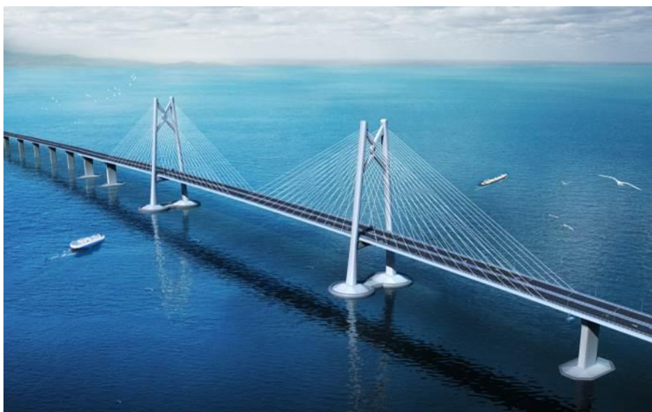
青州航道橋-雙塔雙索面斜張橋(中國結意象)
