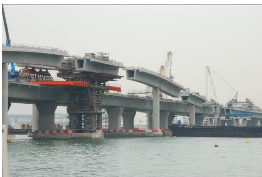
相片20 回轉道處橋梁施工相片
