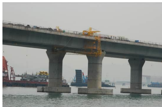
相片21 施工吊具及導航吊燈
