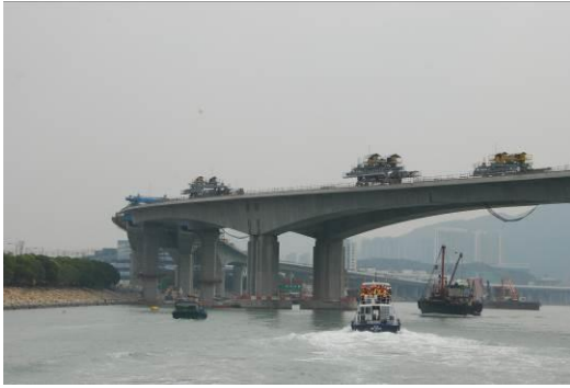
相片14 機場隔離水道跨越橋
