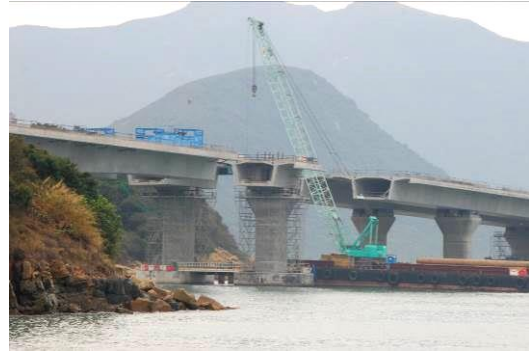
相片23 預力箱型梁斷面
