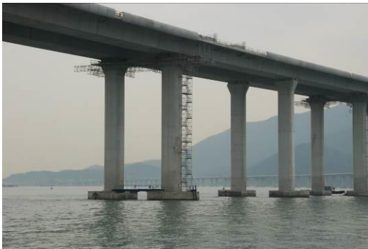
相片24 預鑄橋墩相片
