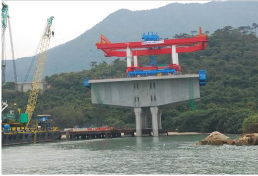
相片22 橋梁節塊吊裝機械
