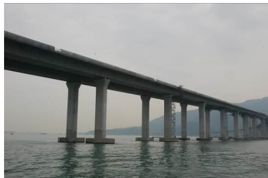
相片19 香港端航道跨越橋(2)
