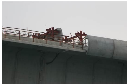
相片25 預鑄橋護欄相片
