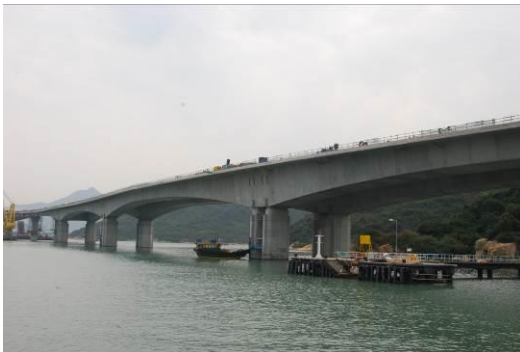
相片16 已閉合之預鑄懸臂橋
