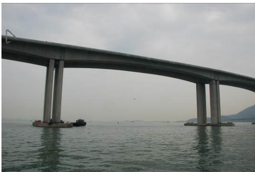
相片18 香港端航道跨越橋(1)
