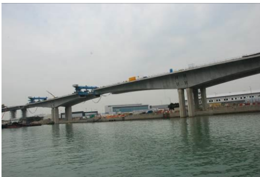
相片12 機場段預鑄懸臂工法
