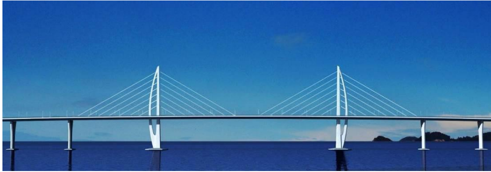
九洲航道橋-雙塔單索面斜張橋(揚帆起航意象)
