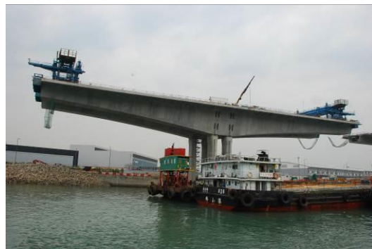
相片13 機場段預鑄懸臂工法
