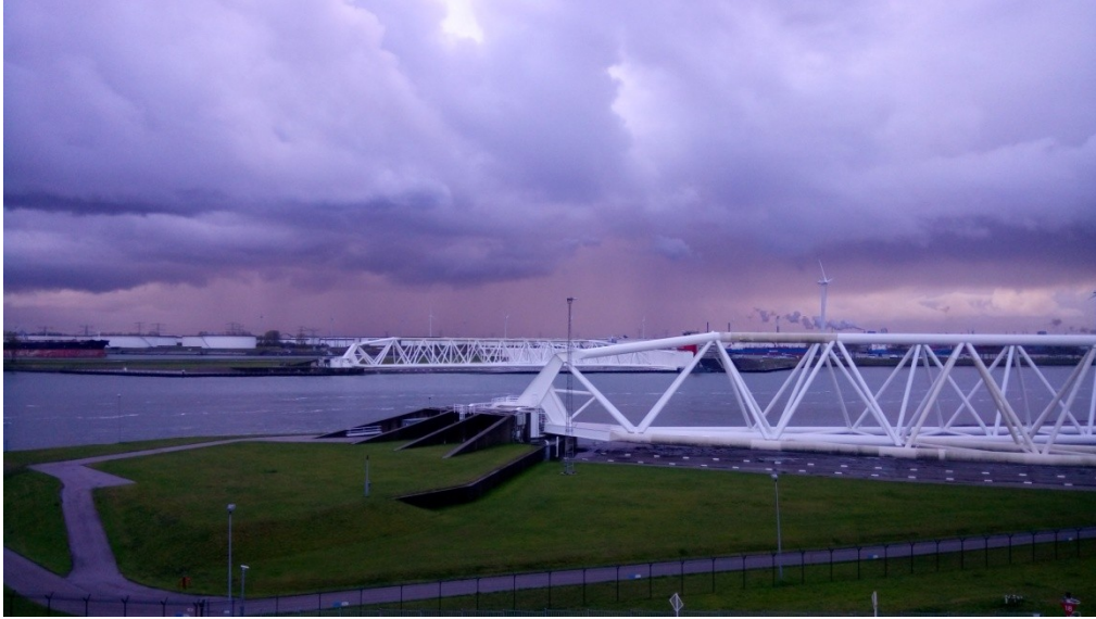
圖 58 參訪荷蘭重要水利設施：馬仕朗防潮閘(Maeslant Barrier)
