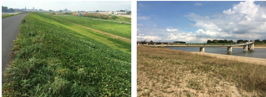
圖 3-6 堤防邊坡，撒草種以提早覆蓋（左）；其他空地，則以裸地，任其植生自然演替（nature process）（右）
