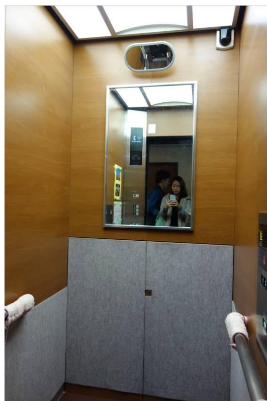
圖6、電梯內部設扶手
