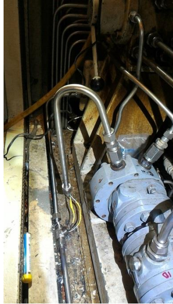
圖 61 77FD3 破皮處理
