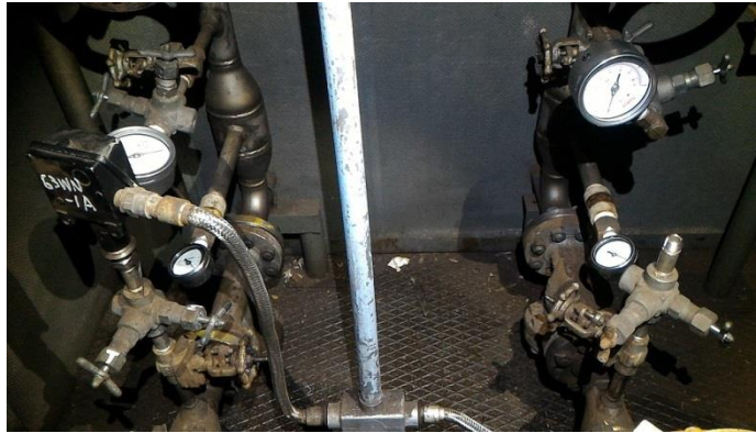
圖 77 CT-1 TI4/5 安裝完畢
