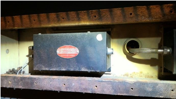
圖 18 更換高壓線(更換前)
