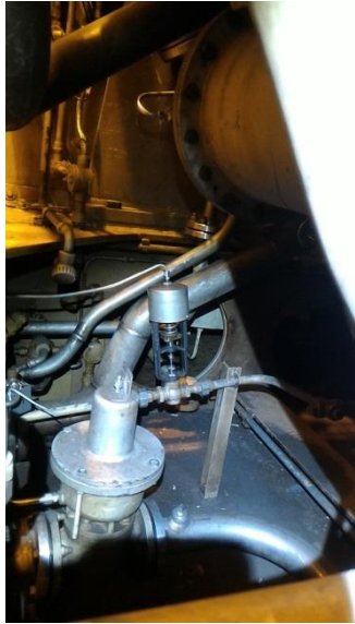
圖 33 CT2 VA17 位置(燃燒室下方)
