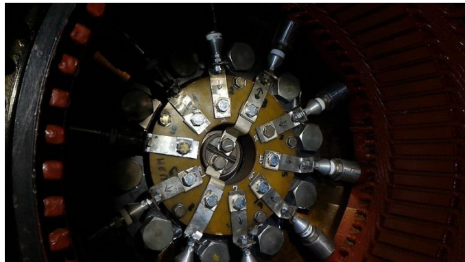
圖 5 二極體安裝完成
