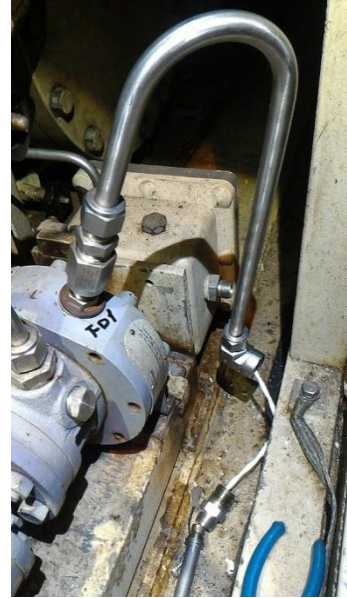
圖 62 CT2 77FD1 更換完成
