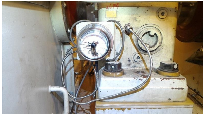
圖 13 CT2 發電機 26P4 於 1/23 安裝完成
