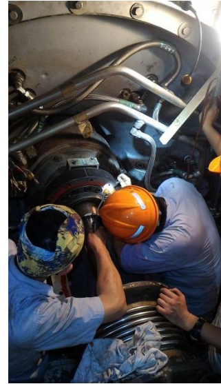
圖 39 氣機轉速偵測器調整間隙
