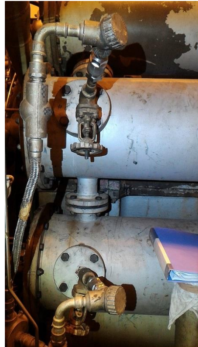
圖 32 燃燒室 Flame Scanner 安裝接線完成
