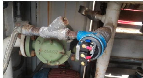
圖 72 壓力開關接 N.O.點
