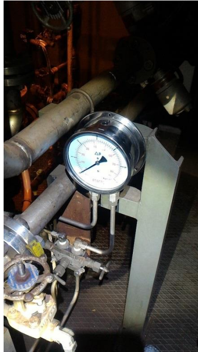
圖 80/81 CT-1/2 Water Injection 系統差壓錶安裝完成
