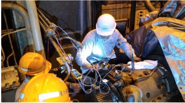
圖 27 CT-1 安裝 Vibration Sensor
