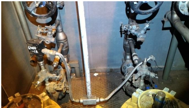
圖 78 CT-1 63WN-1 安裝前
