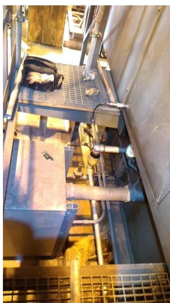
圖 50 移除鐵隔板以方便拆解油位計
