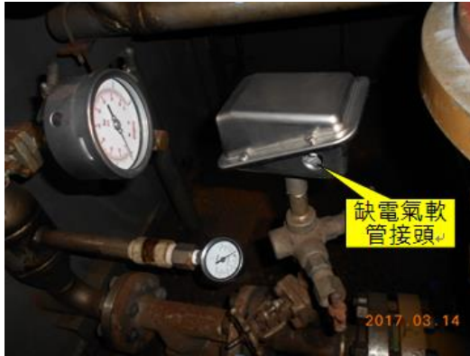
圖 84 CT-2 噴水泵出口壓力開關安裝
