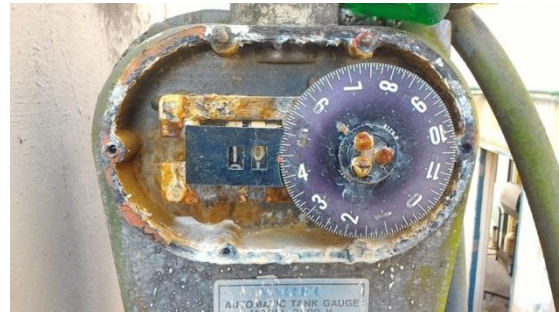
圖 95 調整前現場顯示 10.4，已調至 15 FEET
