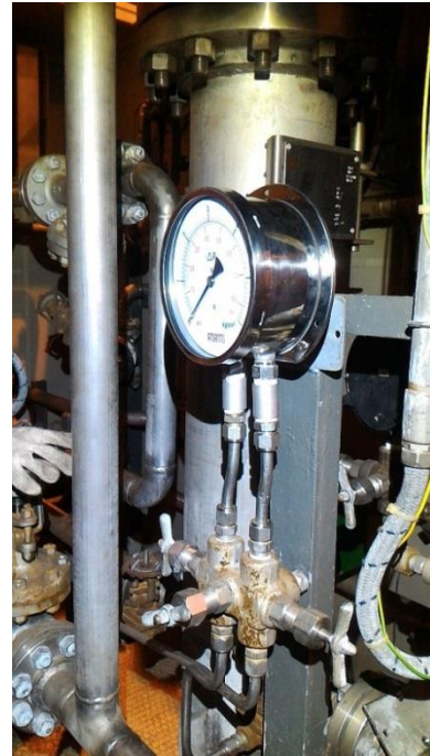
圖 80/81 CT-1/2 Water Injection 系統差壓錶安裝完成
