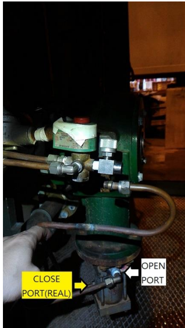
圖 92 CT-2 CV5 開、關連接孔
