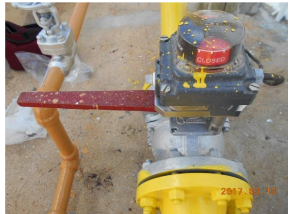
圖 74 手動閥閥位開關安裝定位
