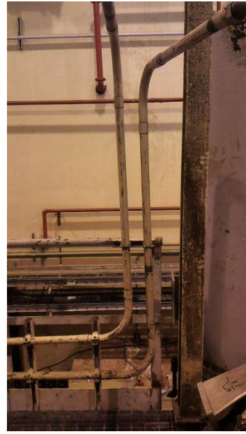
圖 43 導線管屋頂平台固定處
