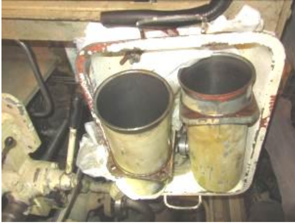
照片 25：液壓油過濾器拆檢
