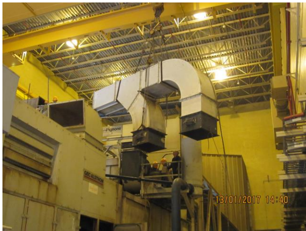
照片 39：氣機室排氣扇風道復裝
