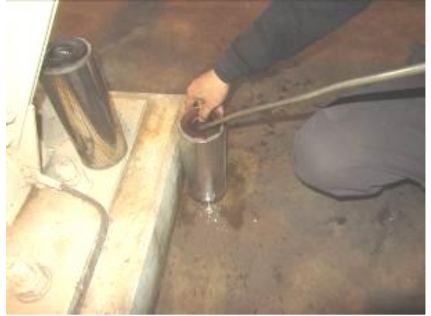
照片 26：液壓油過濾器清理
