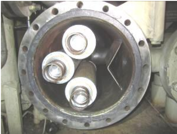
照片 21：主潤滑油過濾器濾網更新
