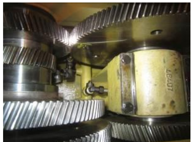
照片 18：起動齒輪箱開蓋檢查
