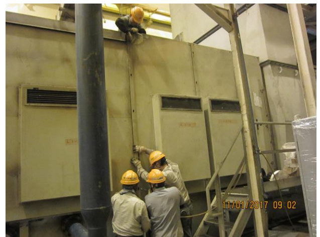
照片 42：氣機室側牆回裝
