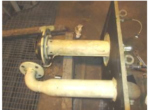
照片 22：輔助潤滑油泵拆檢
