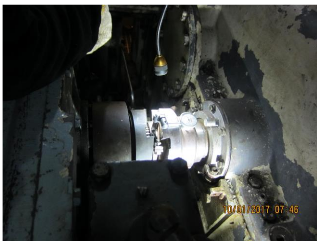
照片 35：起動馬達-輔助齒輪箱對心
