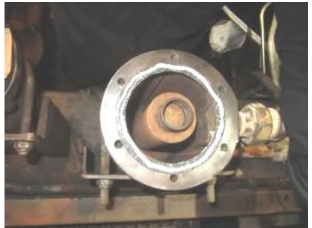
照片 28：儀用空氣過濾器更新
