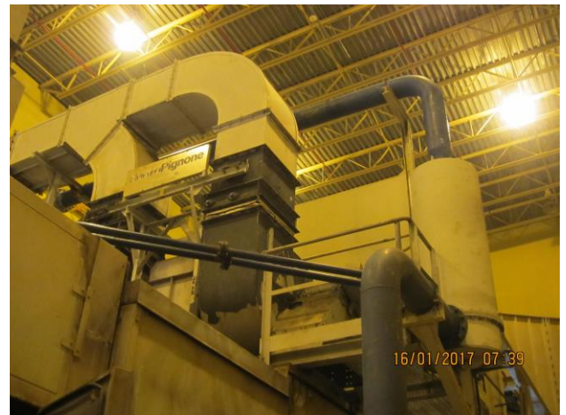
照片 40：油氣分離管復裝
