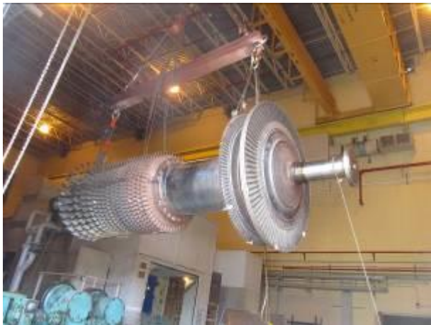
照片 1：氣機轉子吊離
