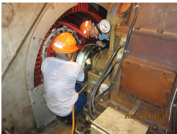
照片 29：發電機-負載齒輪箱對心
