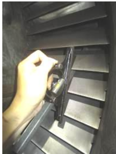
照片 12：IGV 開度角度量測
