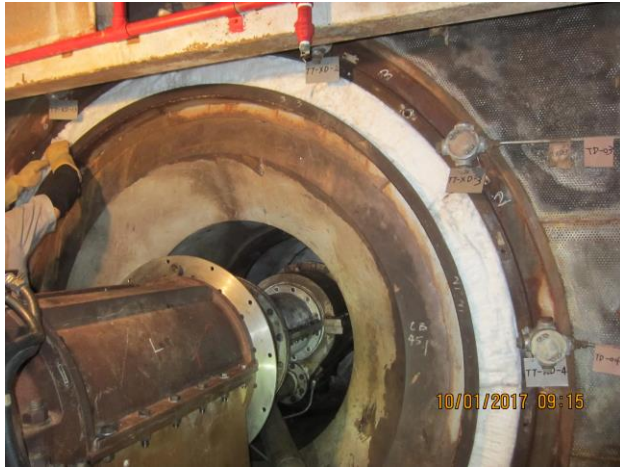
照片 37：排氣擴散器復裝
