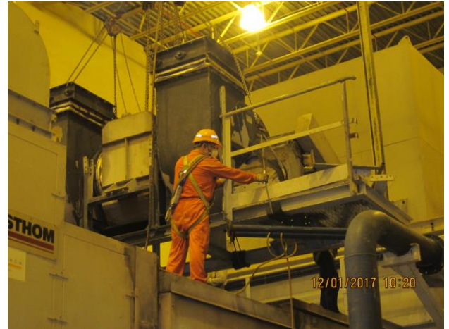
照片 38：氣機室排氣扇復裝
