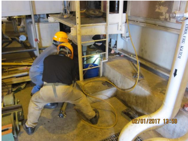
照片 31：發電機座調整
