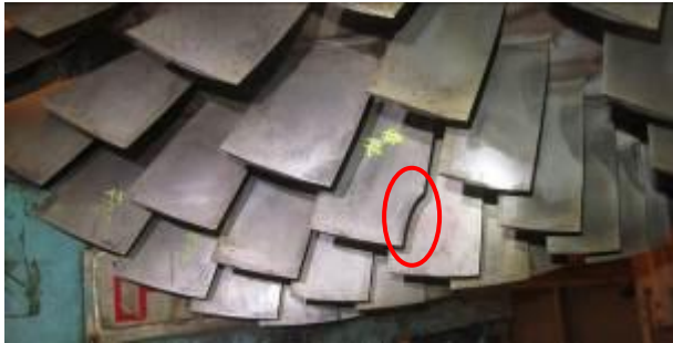
照片 7：CT2 空壓第 2 級#14 動葉片缺陷磨除
