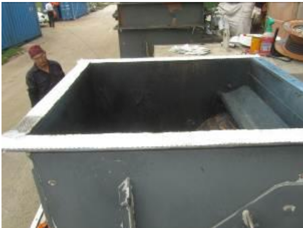
照片 27：排風扇膨脹接頭風管石綿帶更新
