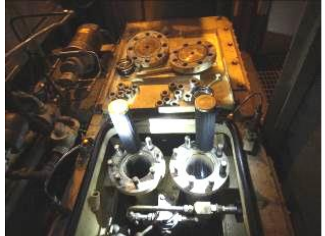
照片 38：液壓油過濾器拆檢
