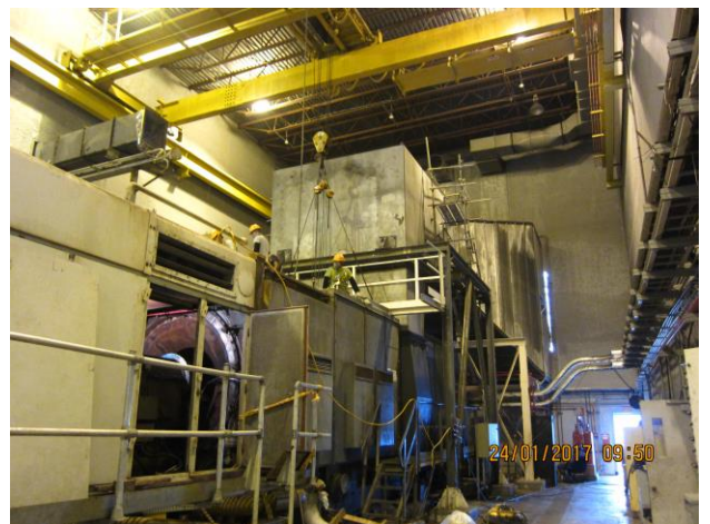
照片 54：氣機室屋頂、側牆回裝
