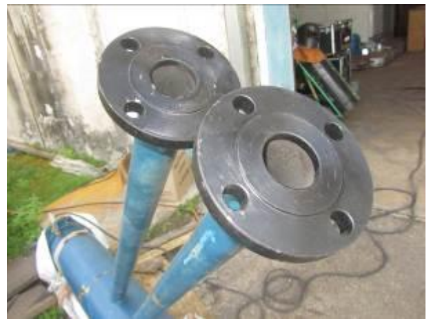
照片 46：管路改銲法蘭
