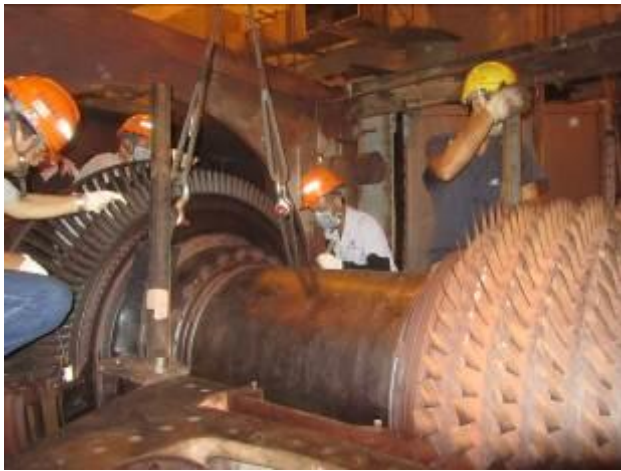
照片 1：氣機轉子吊離
