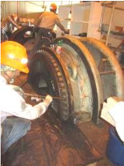
照片 9：IGV 齒隙清理
