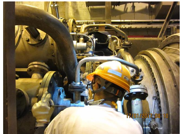
照片 48：燃燒器噴嘴、燃料管回裝
