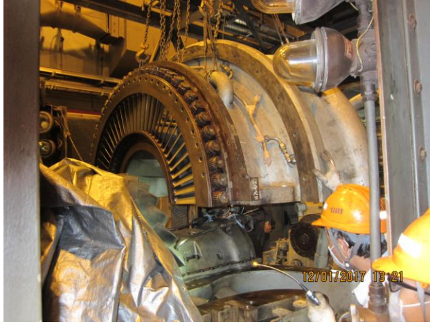
照片 49：空壓機進氣缸回裝
