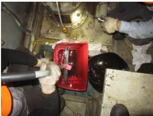
照片 35：潤滑油槽清理
