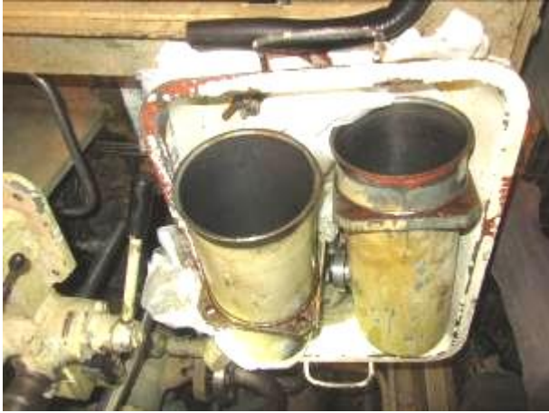
照片 37：液壓油過濾器拆檢
