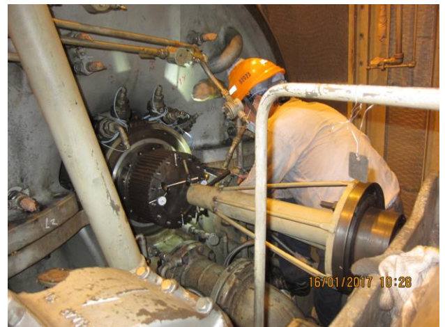
照片 28：空壓機-輔助齒輪箱對心
