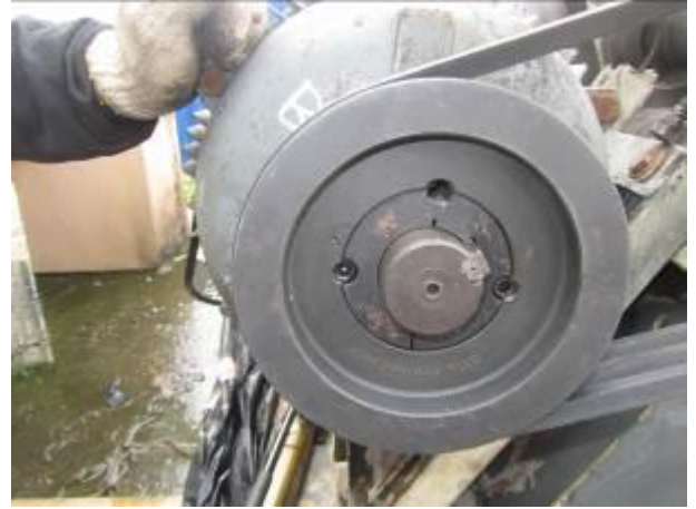
照片 44：排風扇皮帶輪及皮帶更新
