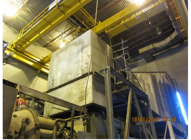
照片 50：進氣道肘管回裝
