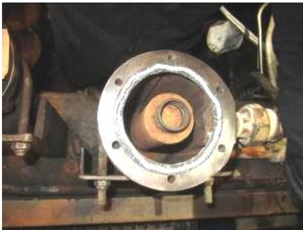
照片 47：儀用空氣過濾器更新
