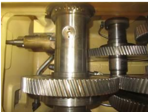
照片 23：起動齒輪箱開蓋檢查
