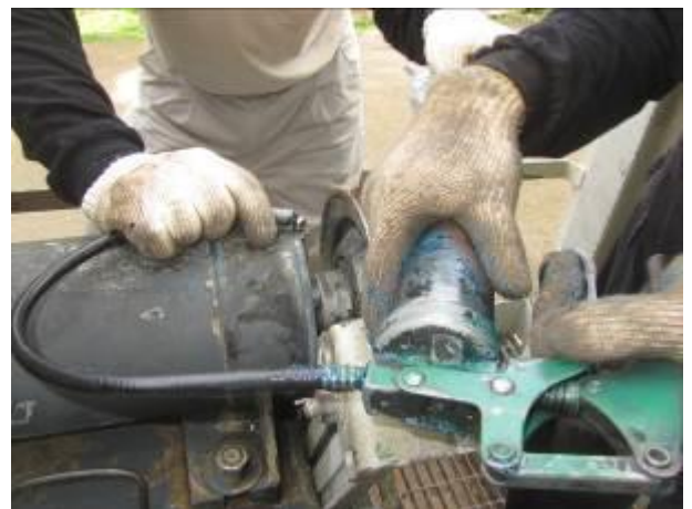
照片 42：更新排風扇油嘴及潤滑油
