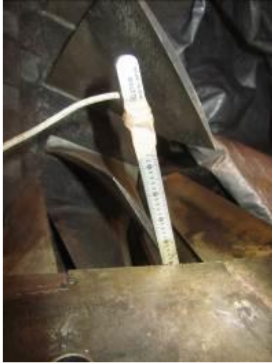
照片 7：空壓機動葉徑向間隙量測
