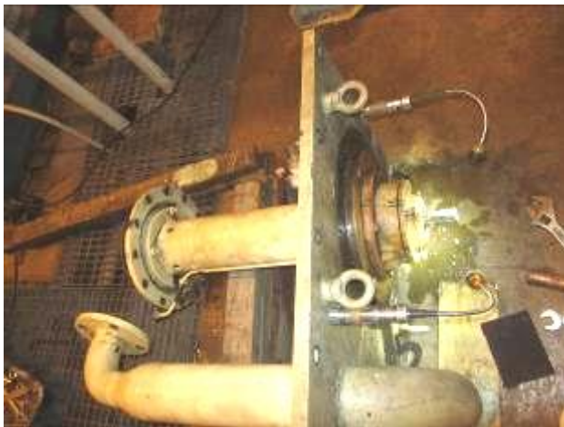
照片 33：輔助潤滑油泵拆檢
