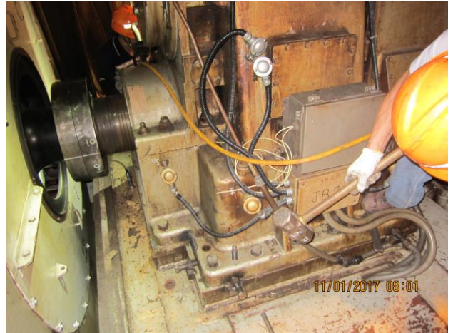
照片 32：發電機-負載齒輪箱對心調整
