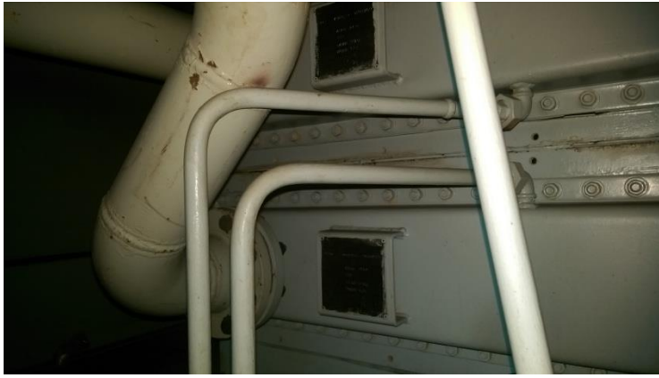
圖 2.7.4 bypass 洩水管無法完全洩水，水垢嚴重堵管
