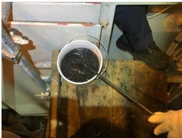
圖 2.7.11 清潔中隨時注意刷頭清潔，太髒立即清潔，損壞立即更換
