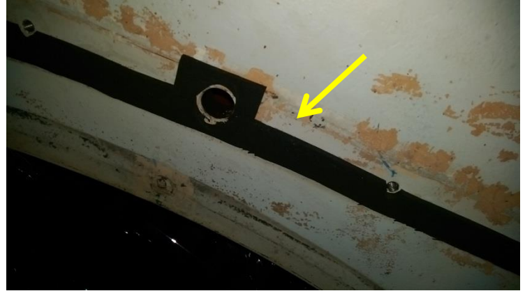
圖 2.2.8 外端蓋換泡棉膠黏貼
