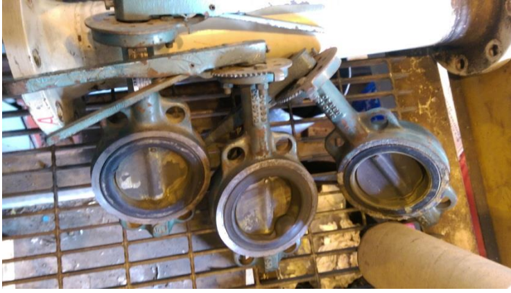
圖 2.7.8 發電機 cooler 進出口閥清潔
