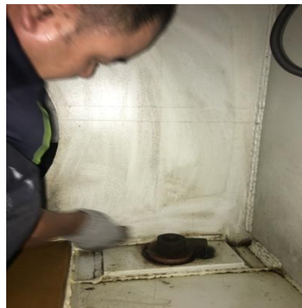
圖 2.2.14 清潔發電機底座&磁場線圈底座
