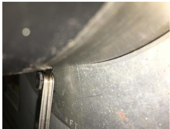
圖 2.2.3 勵磁機內側&外側油封環間隙量測
