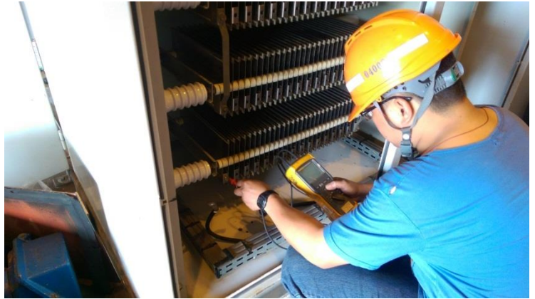
圖 2.3.11 電阻器阻抗測試
