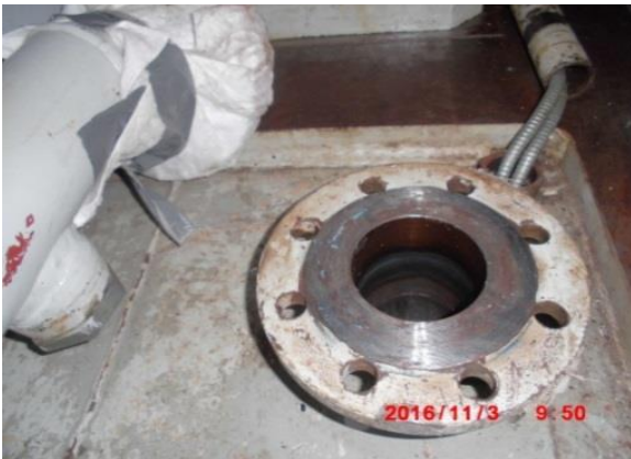
圖 2.2.5 拆卸勵磁機側軸承座上方油管及油孔封口
