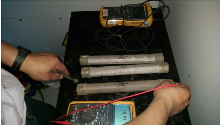
圖 2.3.4 METER PT Fuse 電阻量測
