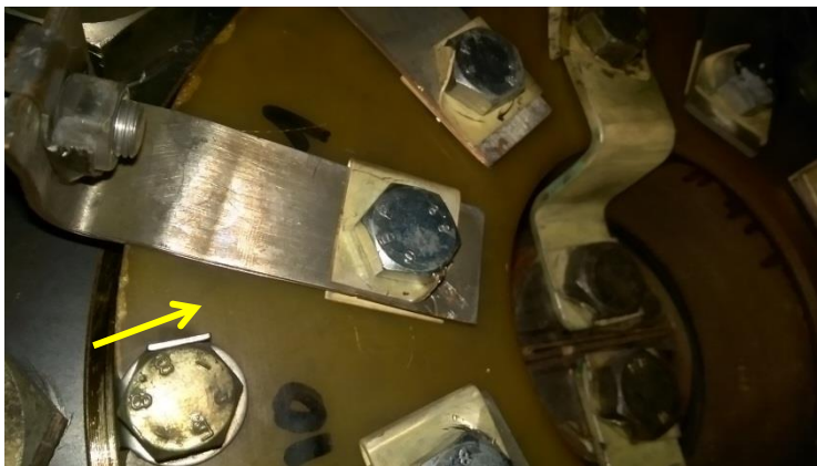
圖 2.1.2 勵磁機整流模組引線近照
