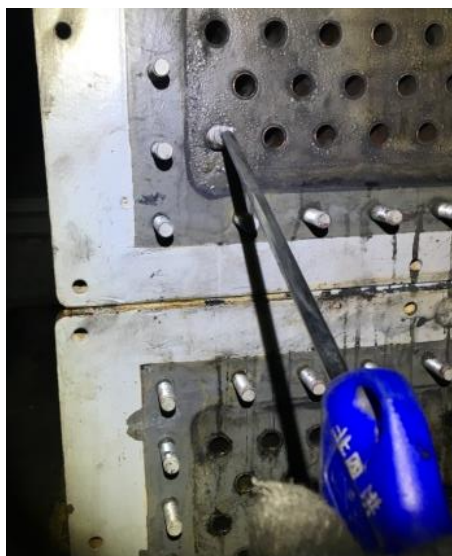
圖 2.7.12 使用乾燥空氣槍再一次清通管路，將表面清潔乾淨
