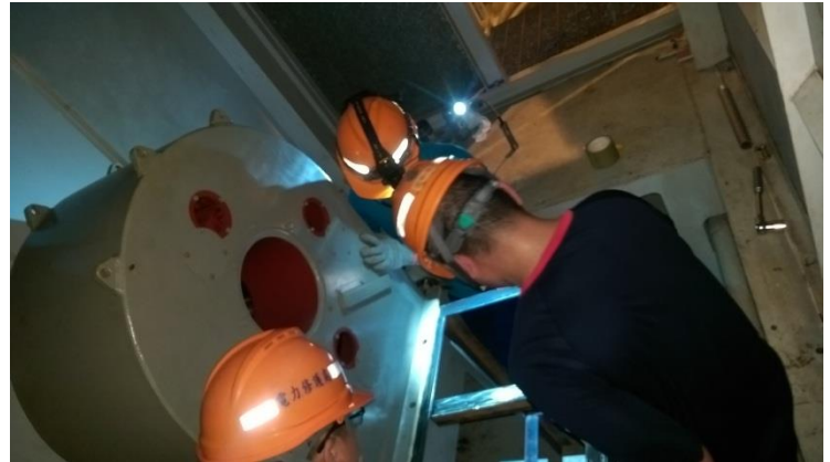
圖 2.2.12 移動磁場線圈，並研究其構造
