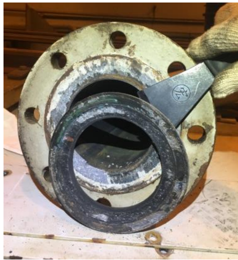
圖 2.7.9 水管法蘭墊片製作
