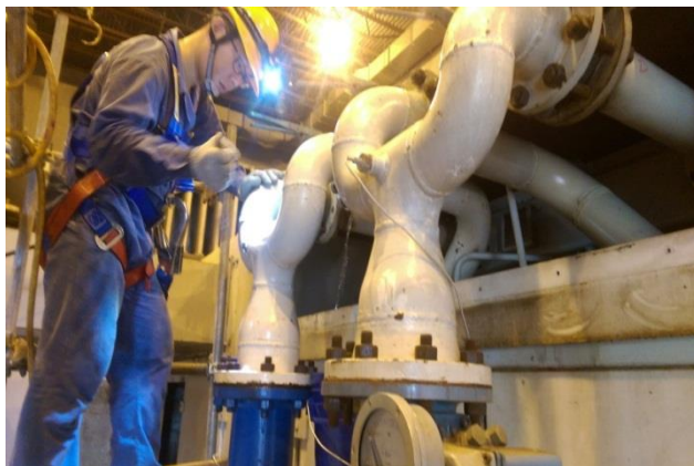
圖 2.7.2 發電機 cooler 洩水作業
