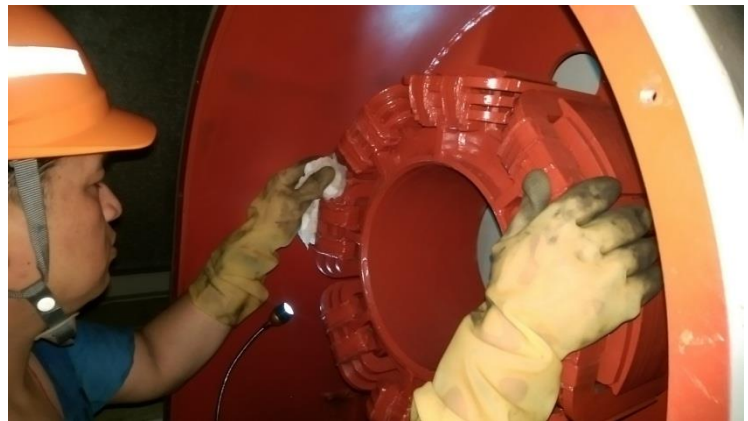
圖 2.1.6 磁場線圈清潔及整理
