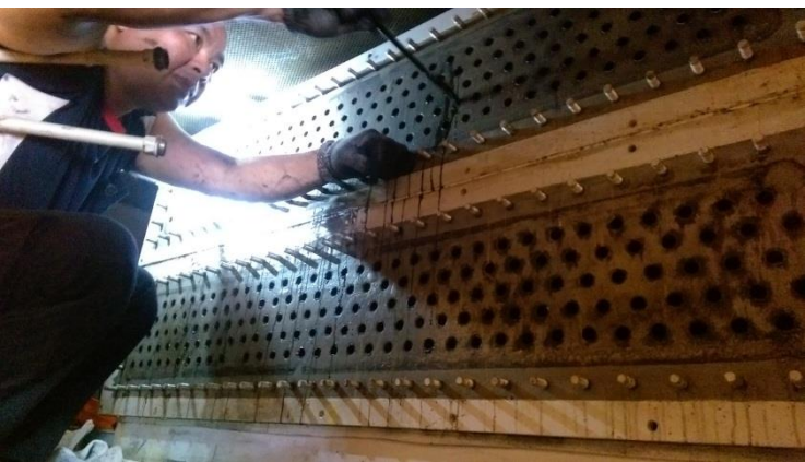
圖 2.7.10 CT1 發電機 COOLER 通管清潔
