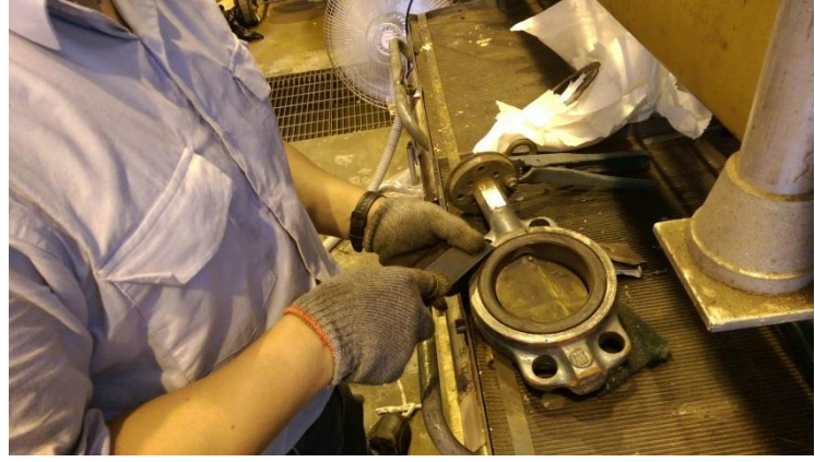
圖 2.7.8 發電機 cooler 進出口閥清潔
