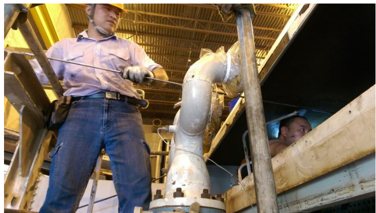
圖 2.7.10 CT1 發電機 COOLER 通管清潔
