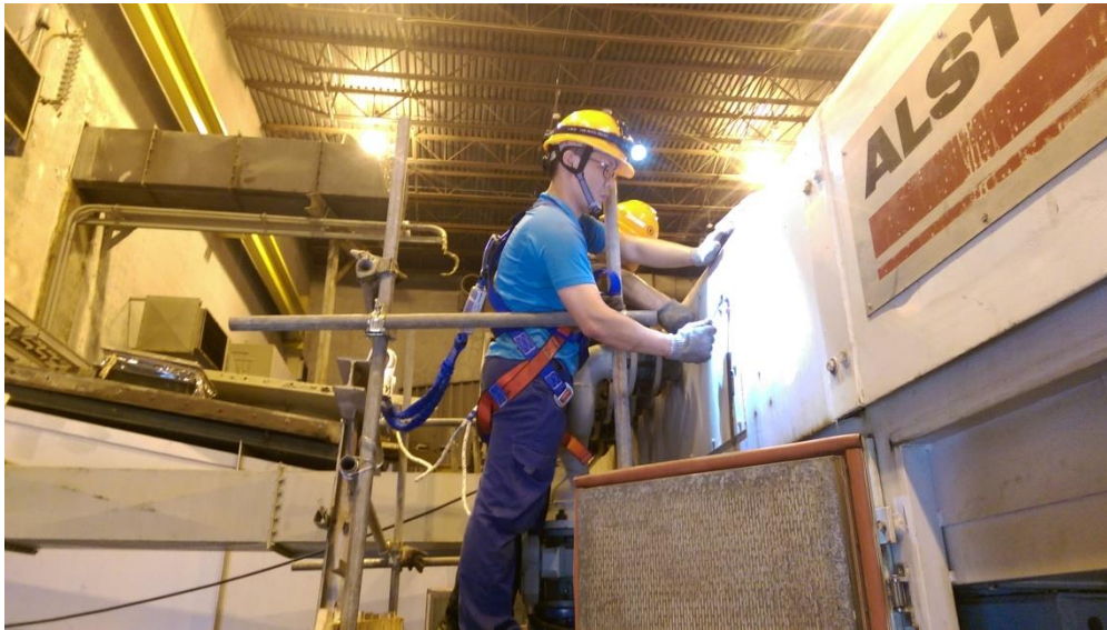
圖 2.7.1 CT1 發電機 cooler 外罩檢查及拆卸
