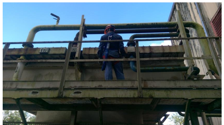
圖 2.7.3 發電機 cooler 洩水，從廠房外部開洩水閘
