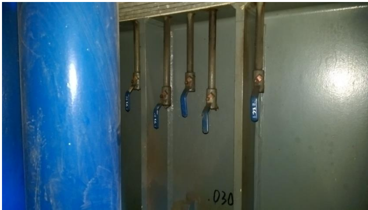
圖 2.7.6 發電機 cooler 進出口水管及馬達
