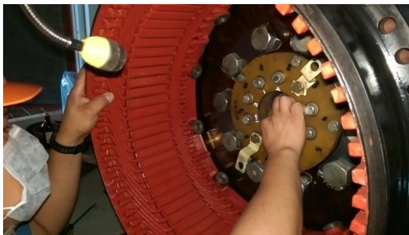
圖 2.6.1 CT#1 發電機轉子極平衡測試
