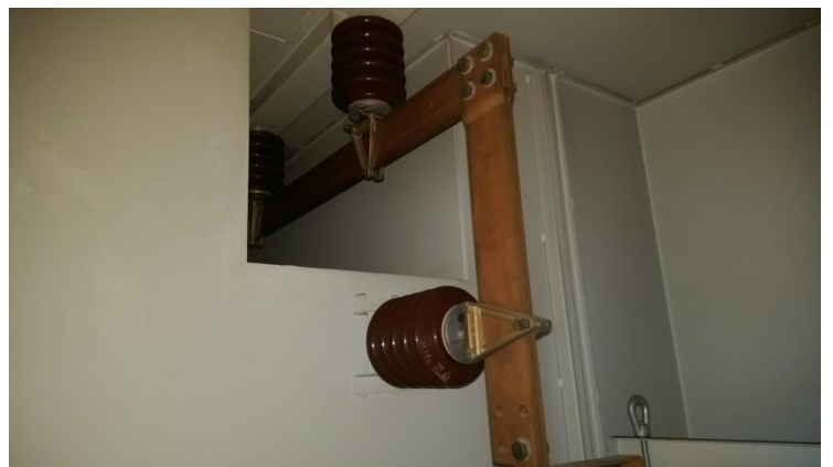
圖 2.3.3 三相 METER PT、後端引線及礙子
