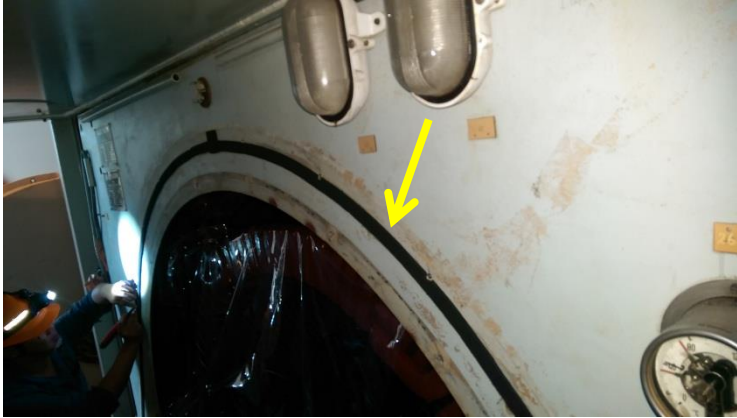
圖 2.2.8 外端蓋換泡棉膠黏貼
