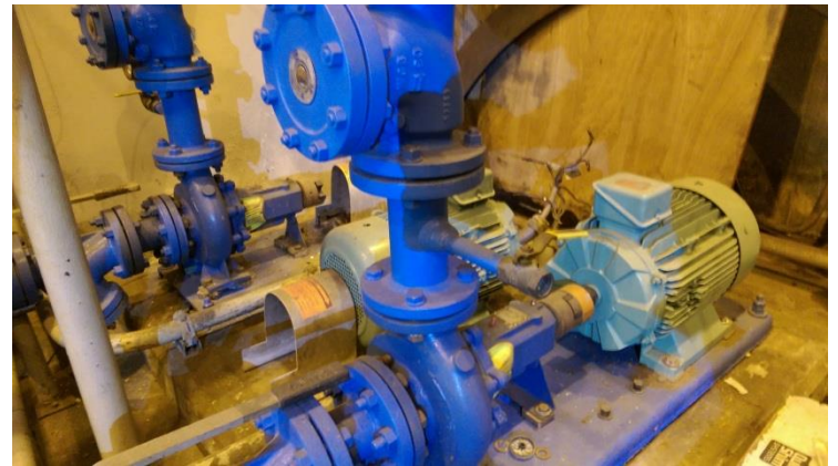
圖 2.7.6 發電機 cooler 進出口水管及馬達
