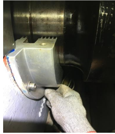
圖 2.2.4 勵磁機內側&外側油封環回裝
