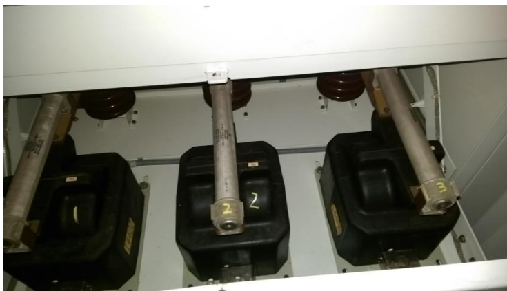
圖 2.3.3 三相 METER PT、後端引線及礙子
