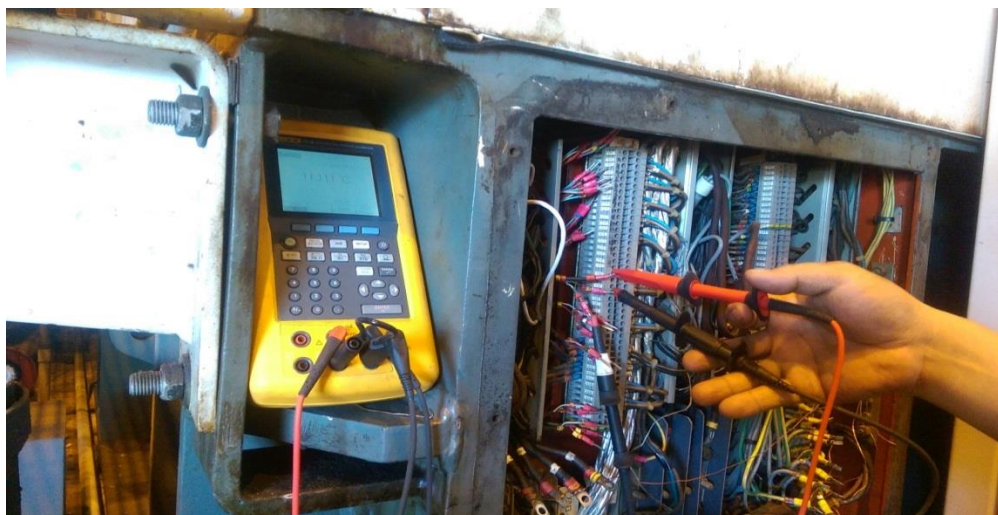
圖 2.5.2 CT1 RTD 電氣測試
