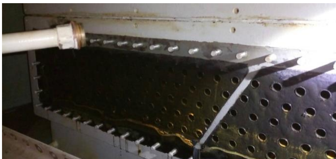
圖 2.7.13 CT1 發電機下層 COOLER 清潔完成圖
