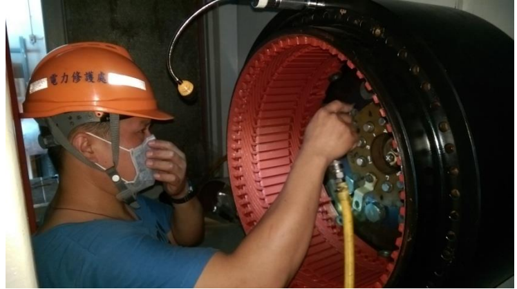
圖 2.1.5 檢查和清潔 armature
