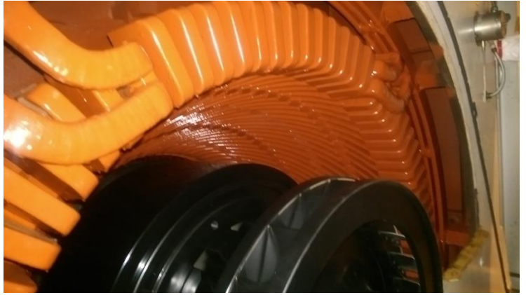
圖 2.4.1 定子線圈 EE 側端部檢查及清潔
