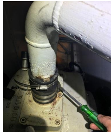
圖 2.2.5 拆卸勵磁機側軸承座上方油管及油孔封口
