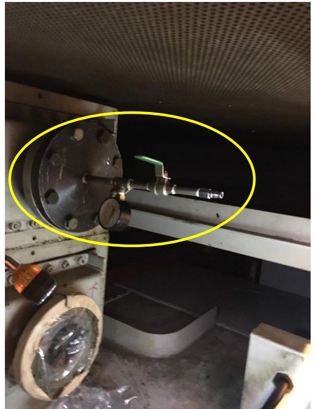
圖 2.7.14 CT1 發電機 COOLER 洩漏測試
