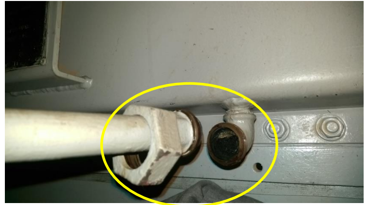
圖 2.7.4 bypass 洩水管無法完全洩水，水垢嚴重堵管
