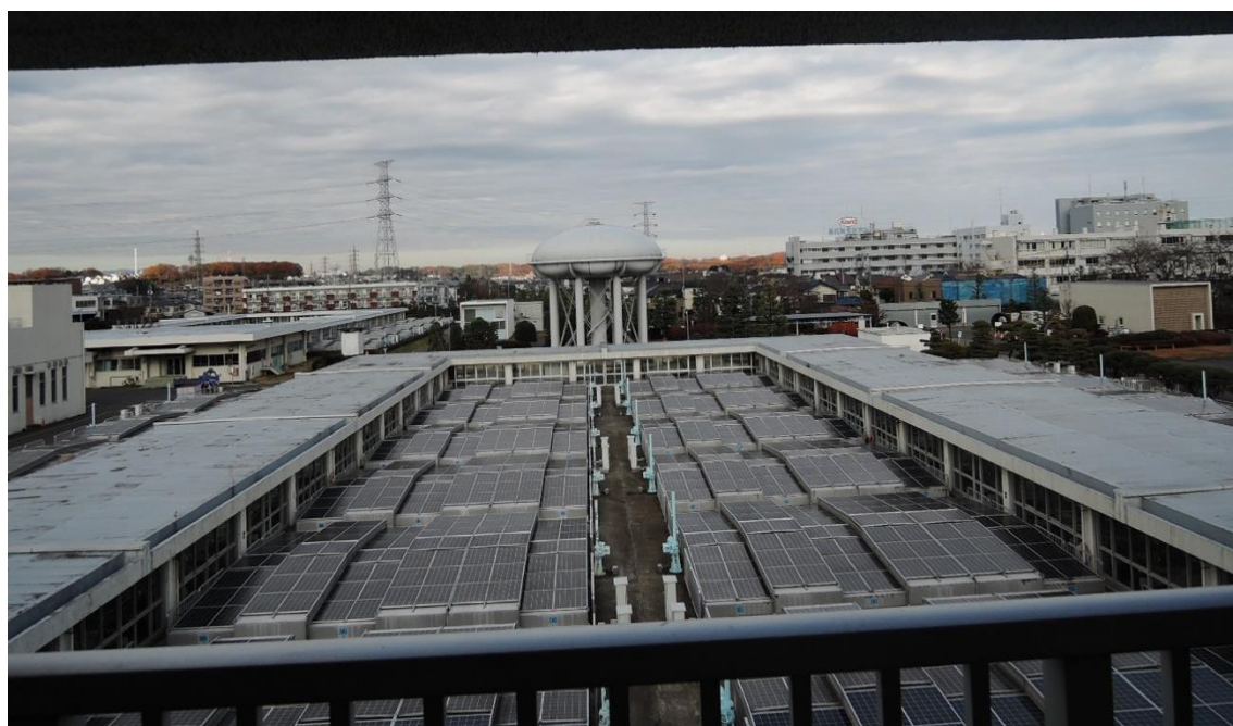
圖 29 東京都水道局東村山淨水場過濾池上加蓋太陽板
