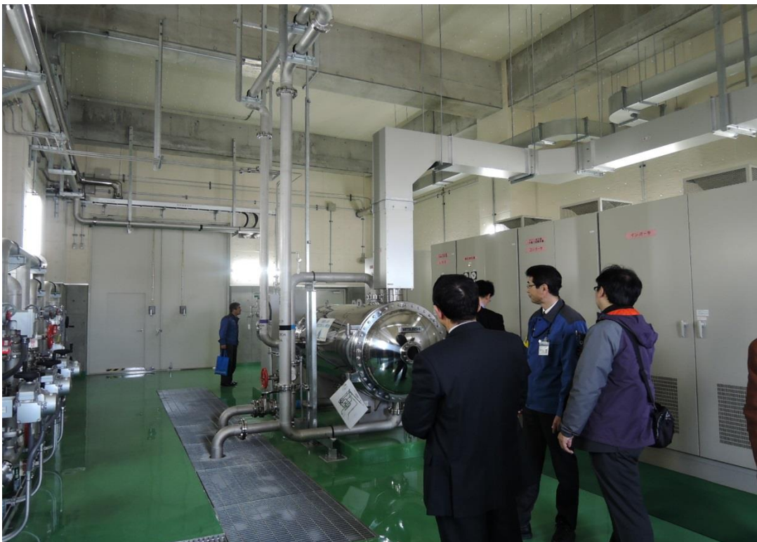
圖 33 東京都水道局東村山淨水場高級處理設備(高濃度臭氧製造設備)
