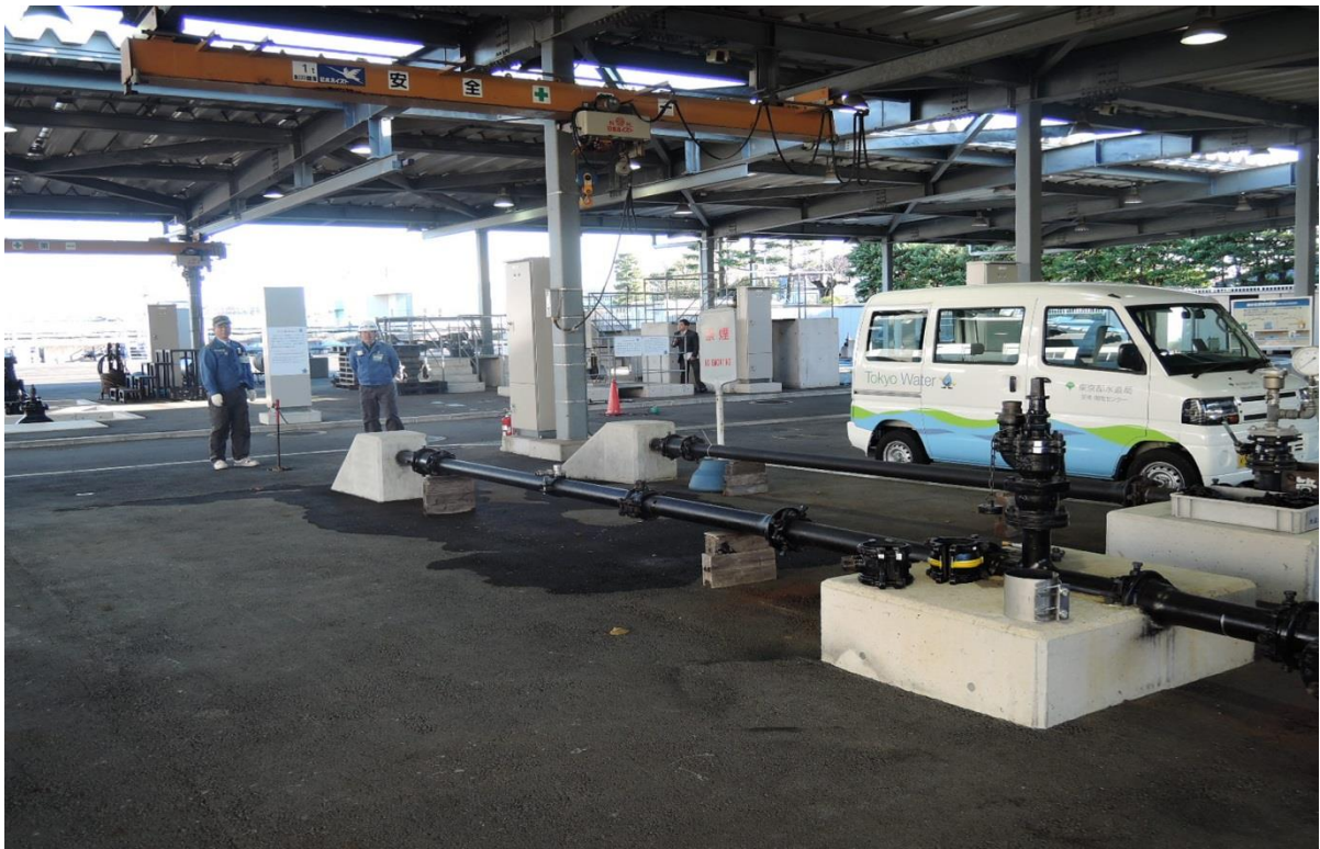
圖 19 東京都水道局教育訓練設施給水安裝實習場
