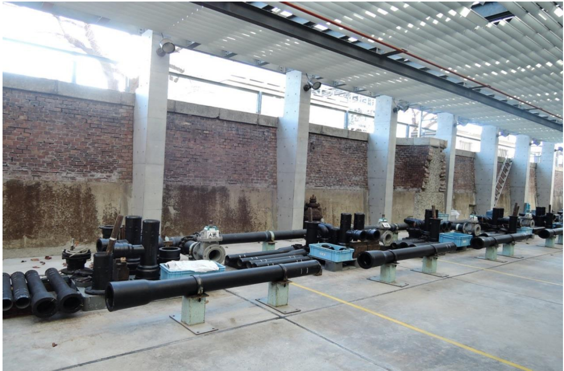
圖 13 東京都水道局教育訓練設施小口徑(75~200m/m) GX 接頭裝配之訓練場地
