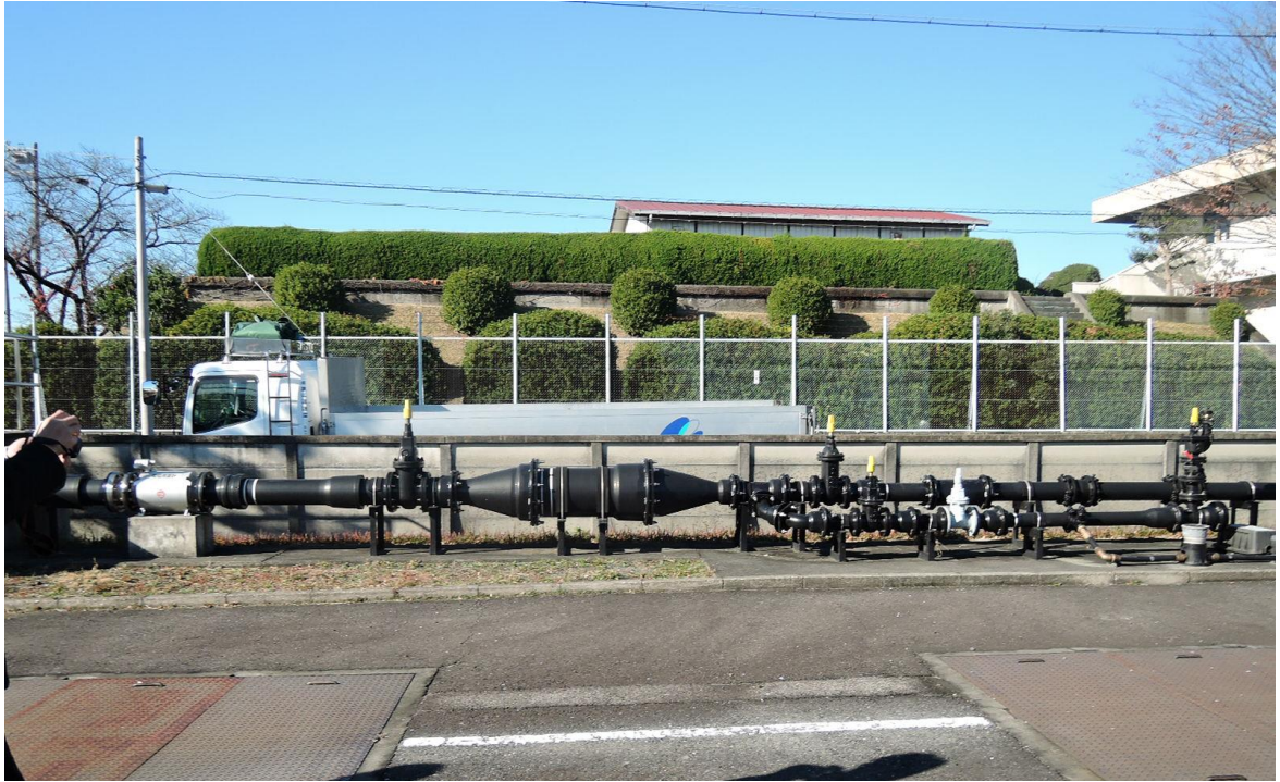
圖 40 名古屋市上下水道局職員研修所管線操作訓練(室外)
