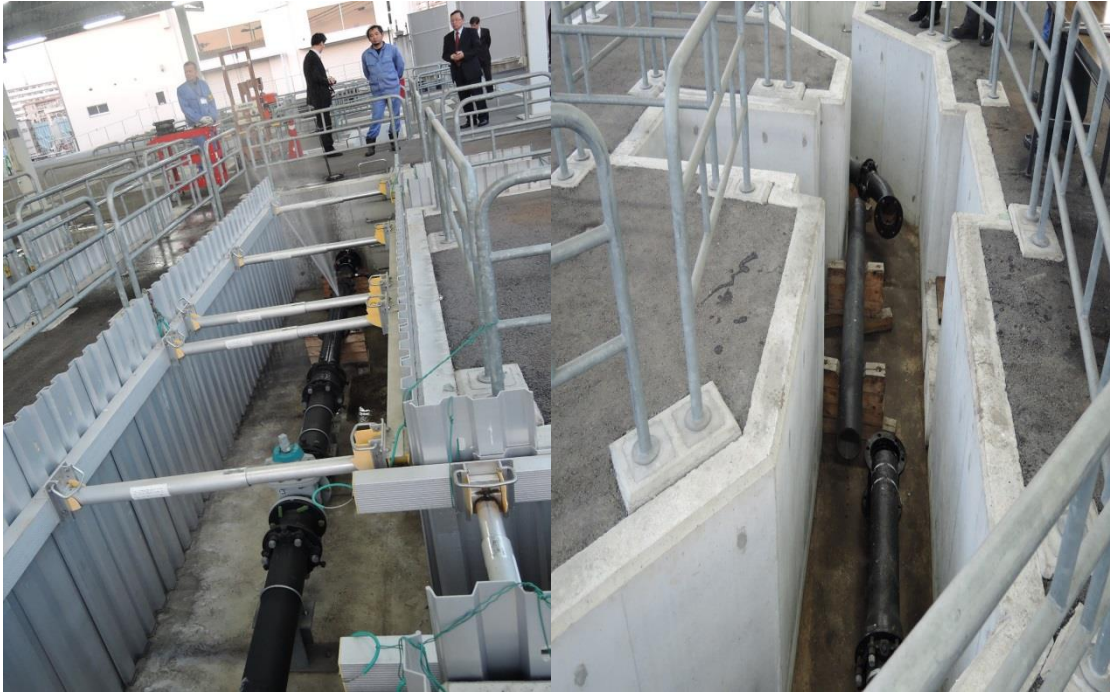
圖 56 大阪水道局職員研修所漏水裝修之訓練場地(地下式)
