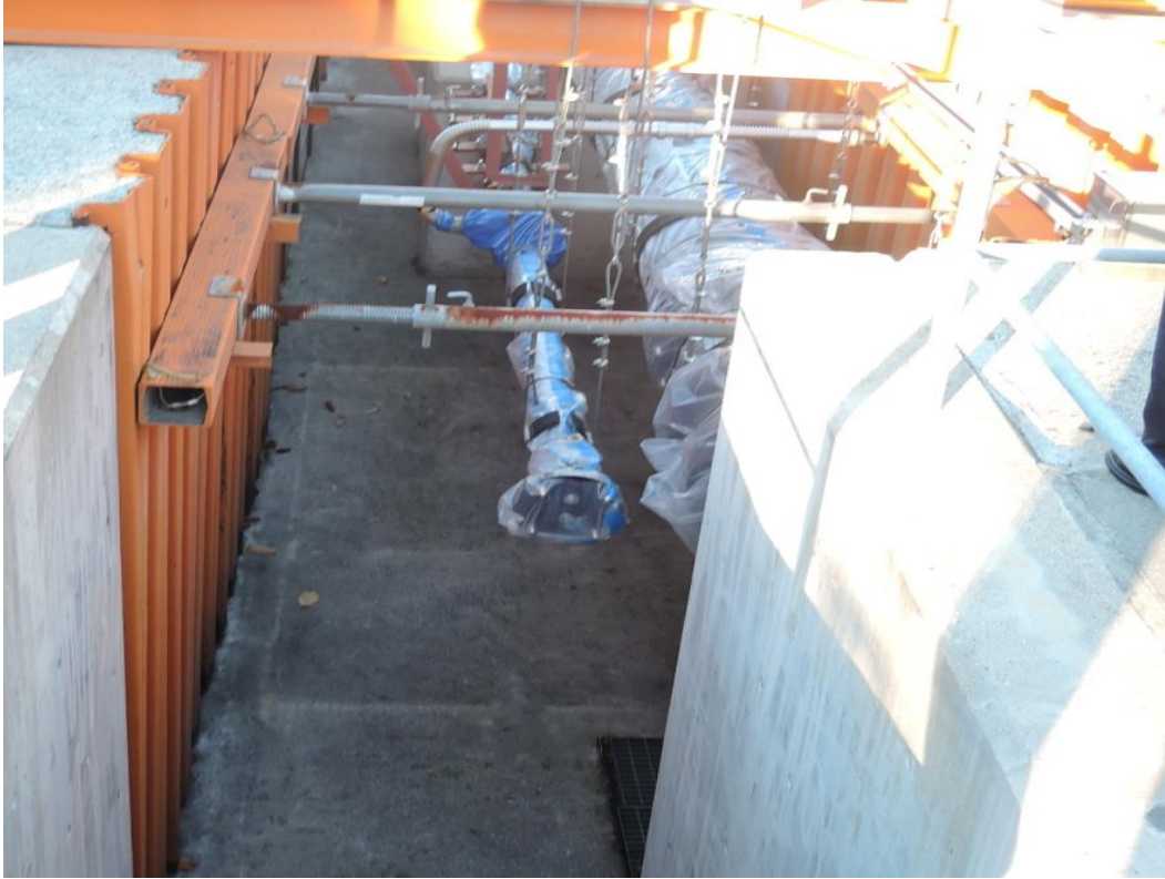
圖 23 東京都水道局教育訓練設施管溝擋土施工介紹
