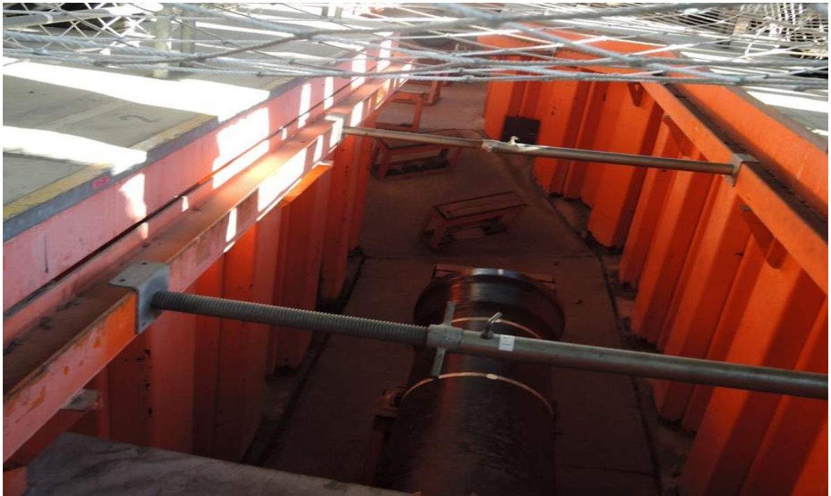
圖 11 東京都水道局教育訓練設施大口徑管線裝接訓練場(地下式)
