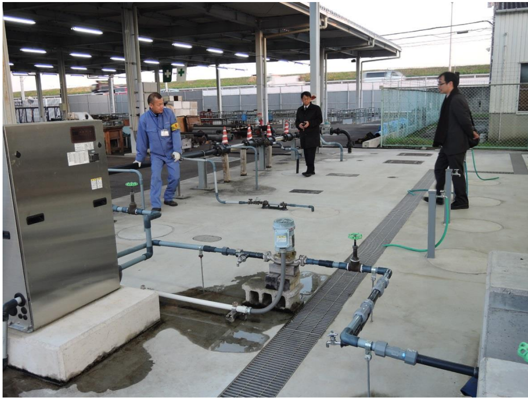
圖 54 大阪水道局職員研修所分水鞍裝配之訓練場地
