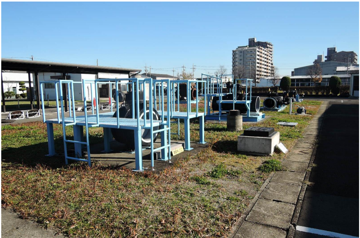
圖 41 名古屋市上下水道局職員研修所閥類開關實習場
