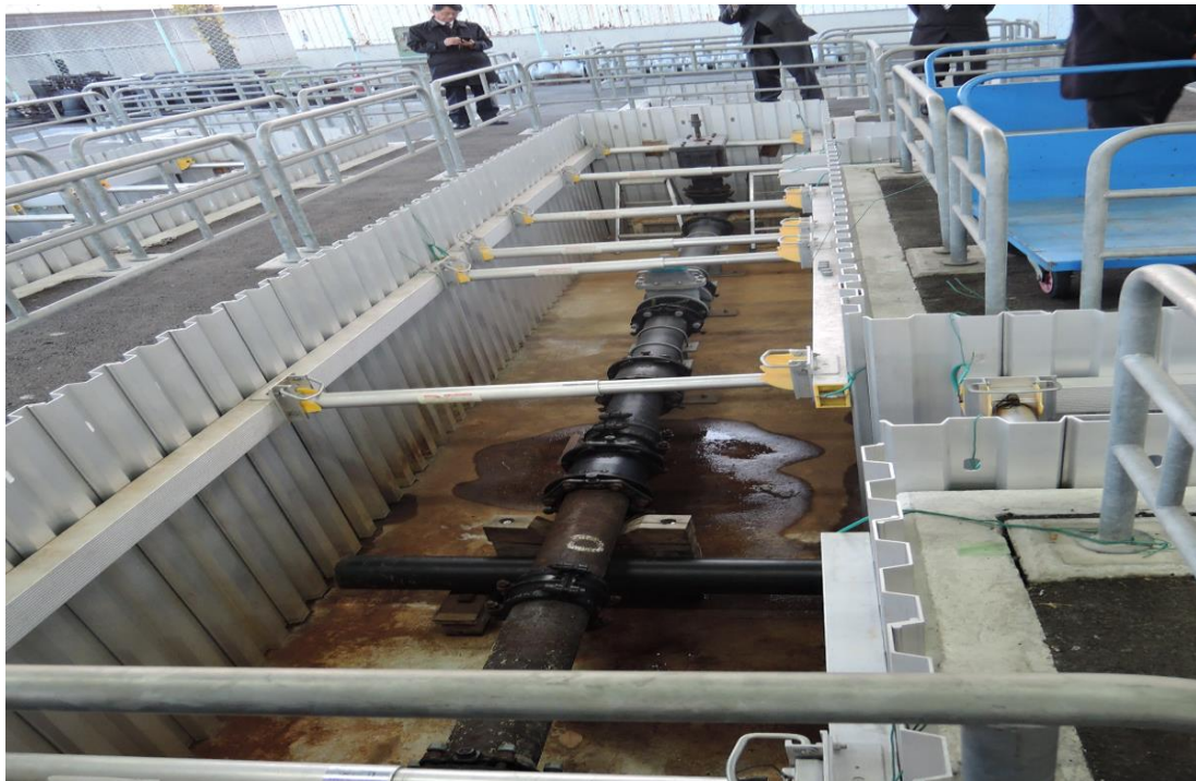
圖 55 大阪水道局職員研修所小口徑裝配之訓練場地(地下式)
